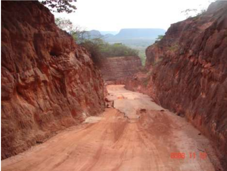
Figura 30 - Estrada de acesso à Comunidade Malícia, Município de Uruçuí – PI
