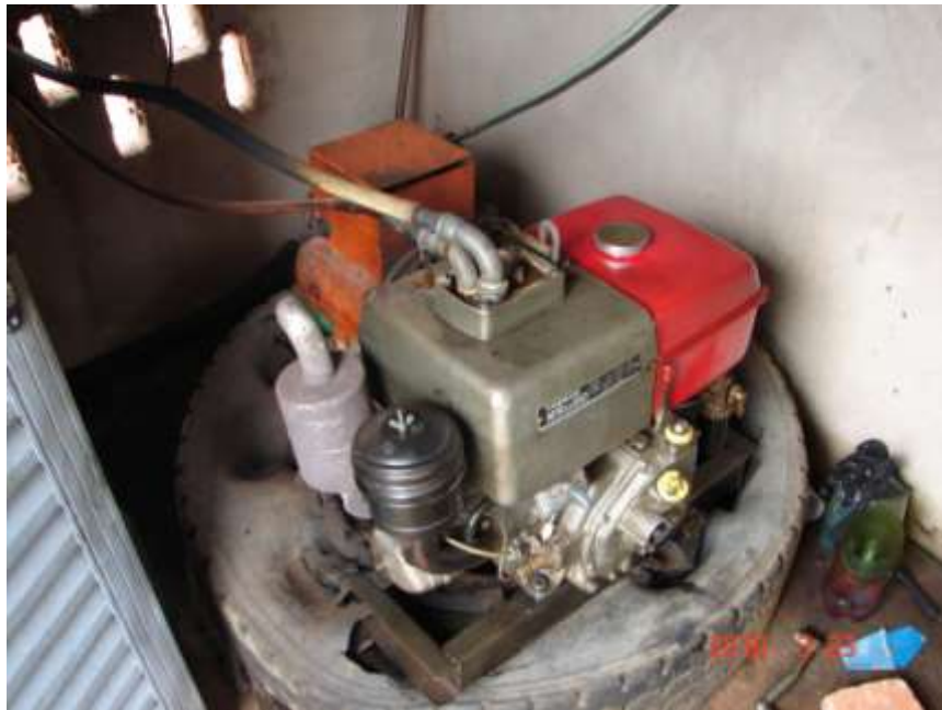
Figura 32 - Grupo-gerador a diesel para bomba submersa da escola na Comunidade Malícia, Uruçuí – PI
