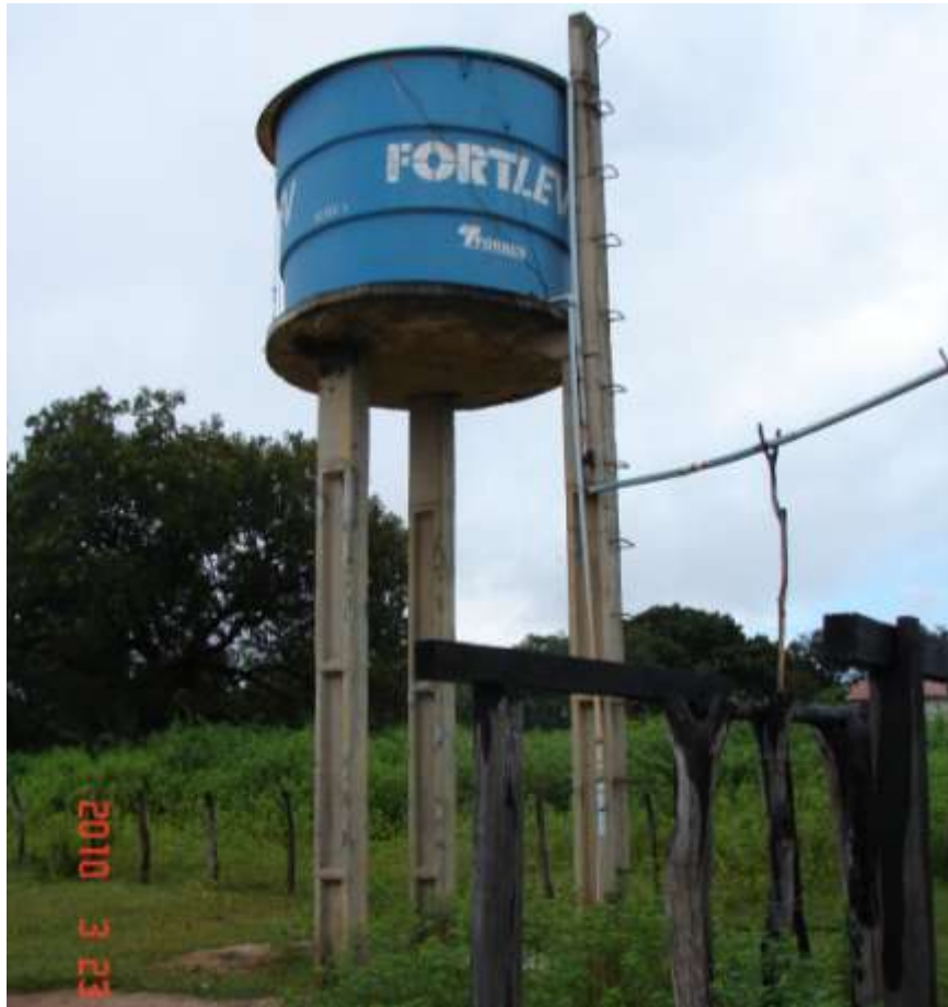
Figura 34 - Sistema de captação d'água, Comunidade Malícia, Município de Uruçuí – PI
