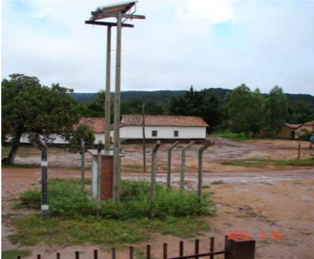
Figura 51 - Estrutura com painéis montados – Localidade Malícia
