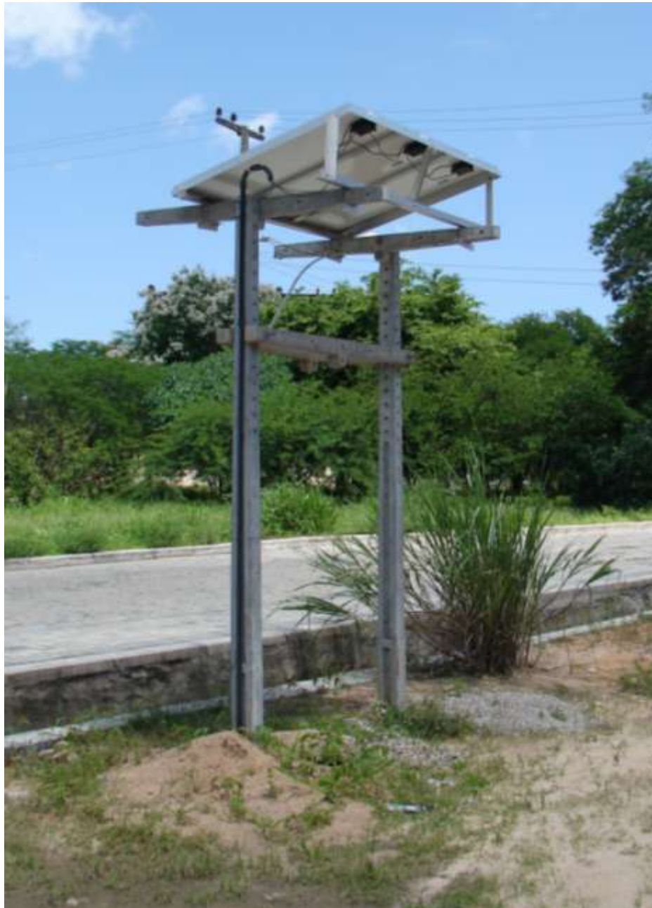
Figura 53 - Estrutura com painéis montados – Universidade Federal do Ceará
