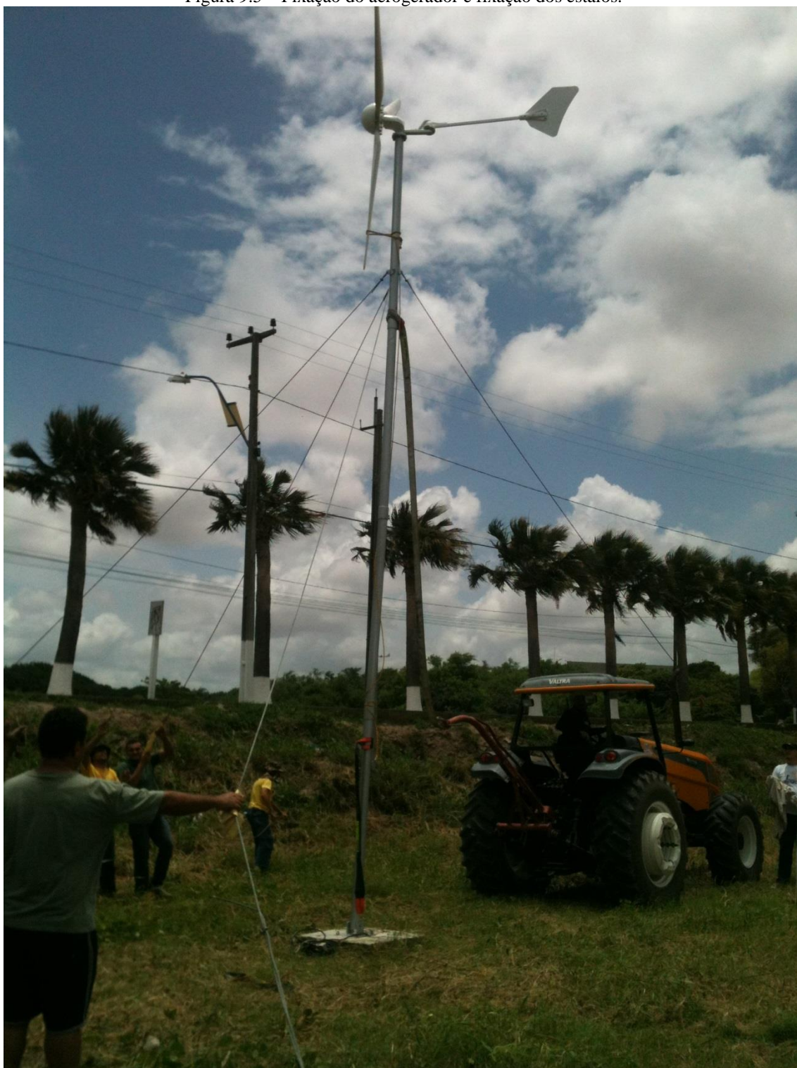
Figura 9.5 – Fixação do aerogerador e fixação dos estaios.
