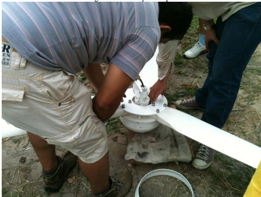
Figura 9.1 – Fixação das pás.
