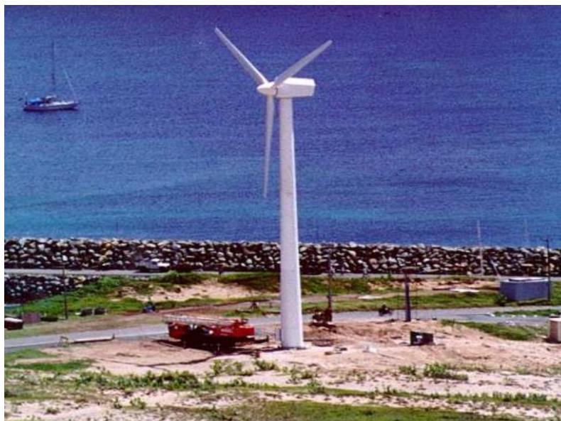
Figura 3.1 - Instalação do segundo aerogerador em Fernando de Noronha.
