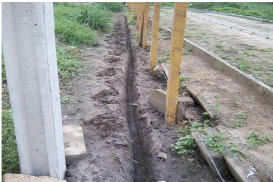
Figura 4.7 - Instalação do cabo para conexão do aerogerador até o abrigo.
