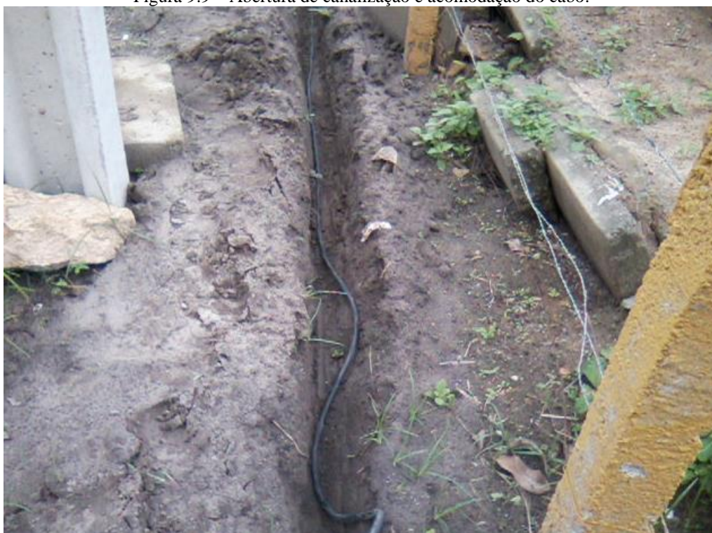
Figura 9.9 – Abertura de canalização e acomodação do cabo.
