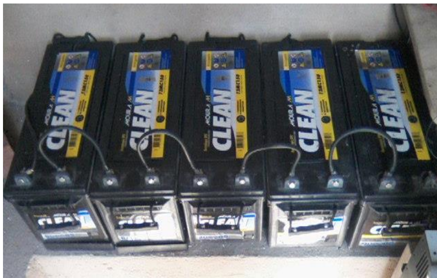
Figura 4.8 - Banco de baterias em série.
