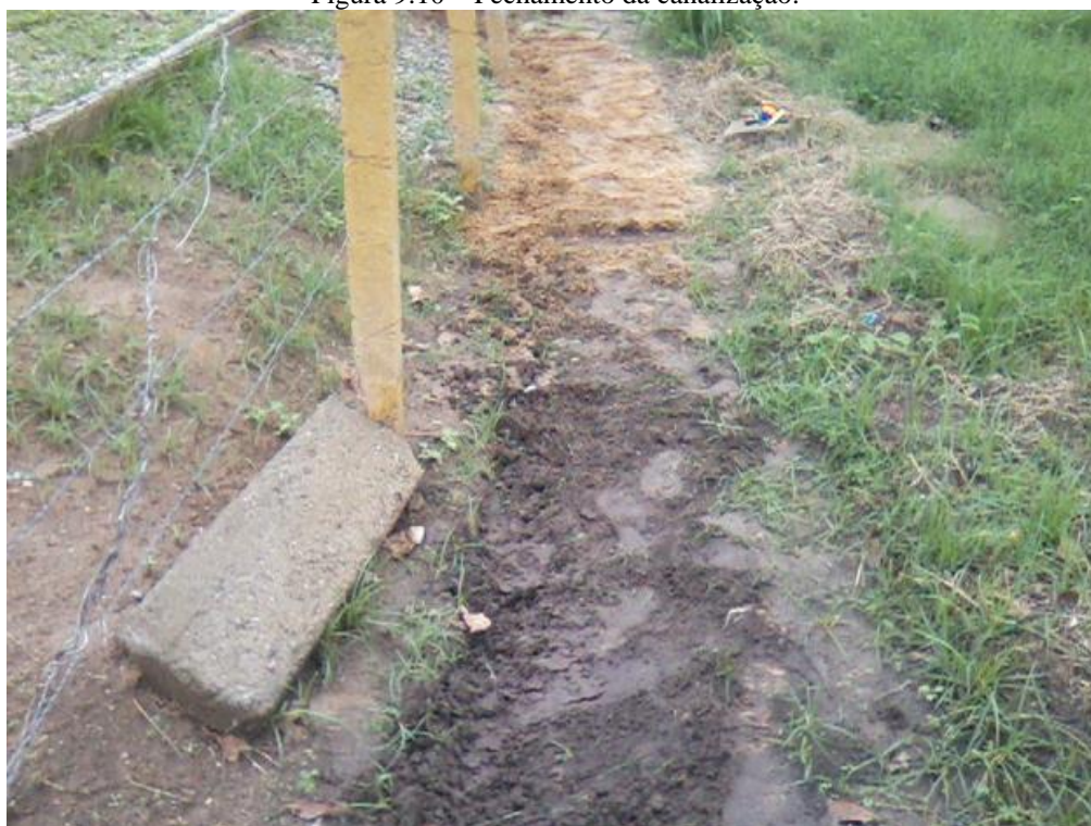
Figura 9.10 – Fechamento da canalização.
