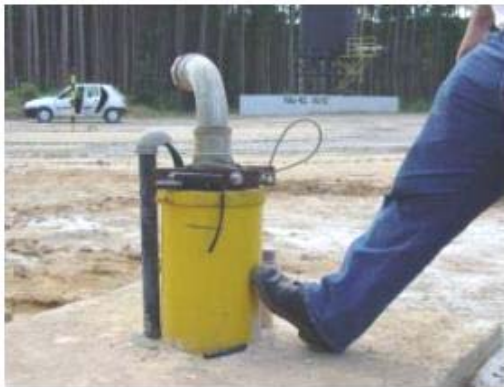
Figura 84 - Poço FAL-42 construído e com equipamento de extração de água.
