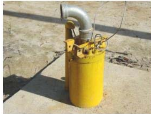
Figura 85 - Poço FAL-40 construído e com equipamento de extração de água.
