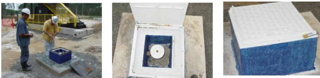
Figura 87 - Piezômetros construídos na área de pesquisa com caixa de proteção em alvenaria.
