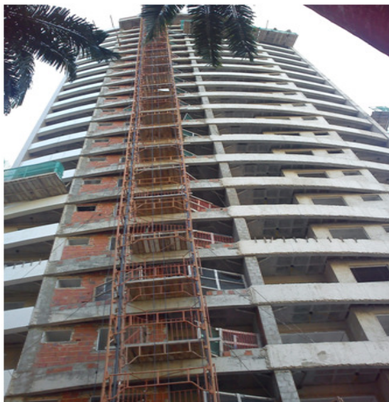
Figura 75 - Proteção parcial dos vãos abertos de fachada
