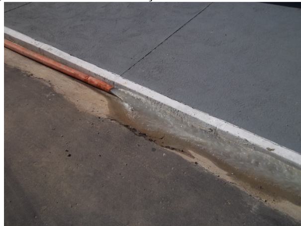
Figura 13 - Remoção das águas do rebaixamento do lençol freático
