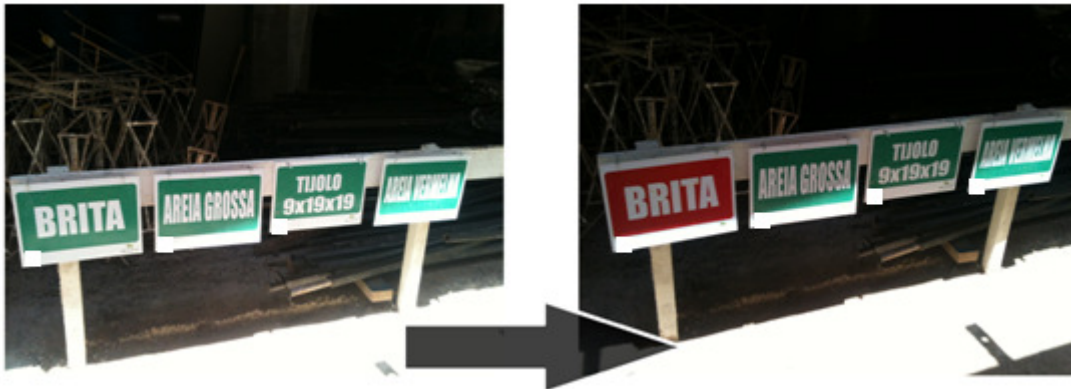
Figura 32 - Sinalização de estoque e necessidade de compra de materiais
