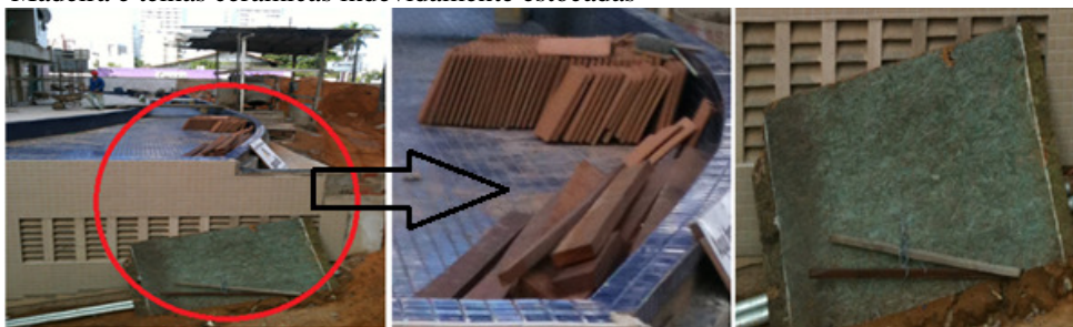
Figura 78 - Madeira e telhas cerâmicas indevidamente estocadas
