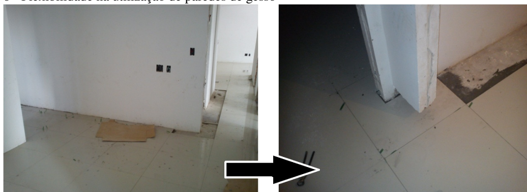
Figura 76 - Flexibilidade na utilização de paredes de gesso
