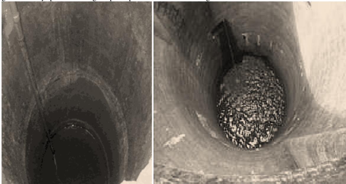
Figura 73 - Poço profundo antigo exposto para uso alternativo de água
