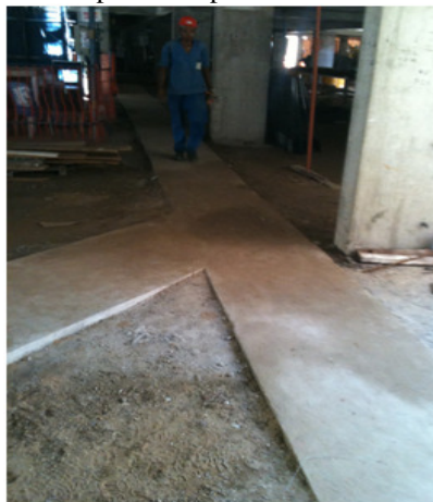
Figura 33 - Via de circulação de funcionários para transportes
