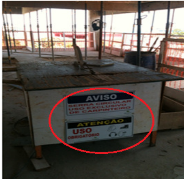
Figura 30 - Mesas de corte dispostas em todos os pavimentos
