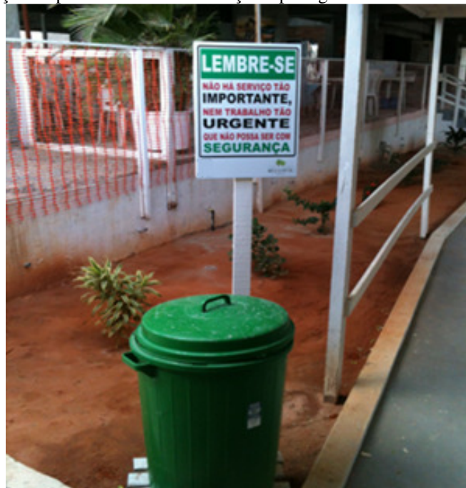
Figura 19 - Via de circulação de pedestres com urbanização e paisagismo
