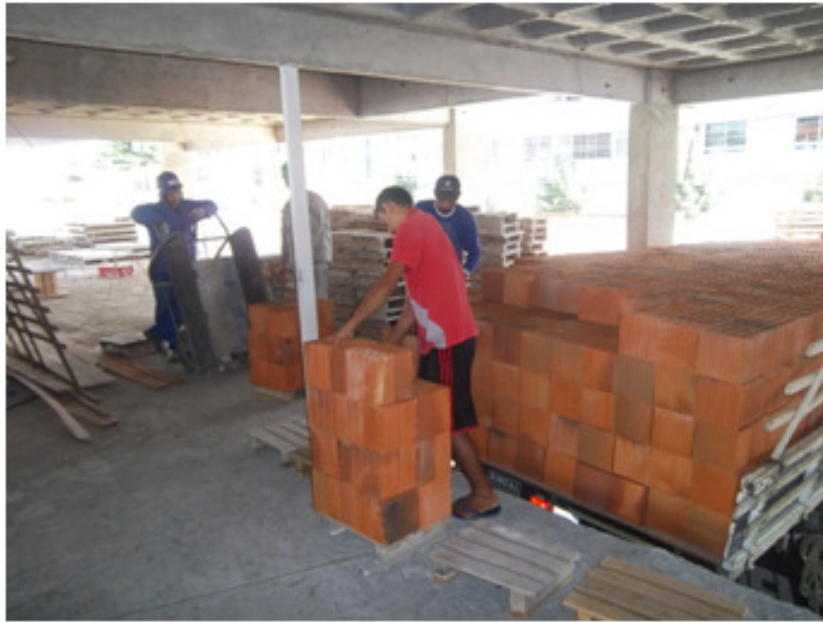
Figura 16 - Transporte de material por pallet e falta de uso de EPI de um funcionário
