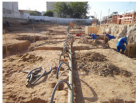
Figura 13 - Remoção das águas do rebaixamento do lençol freático
