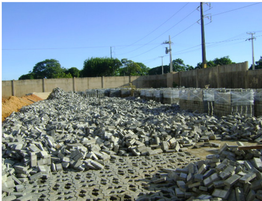
Figura 69 - Acumulo indevido de resíduos e materiais utilizáveis
