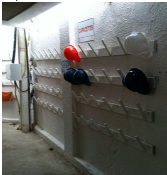
Figura 17 - Disponibilização de capacetes na entrada da obra
