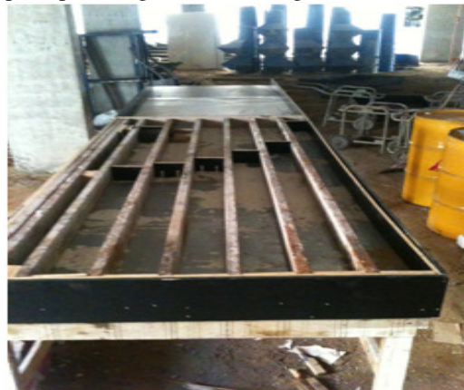
Figura 35 - Mesa de fôrmas completa para vergas e contra-vergas
