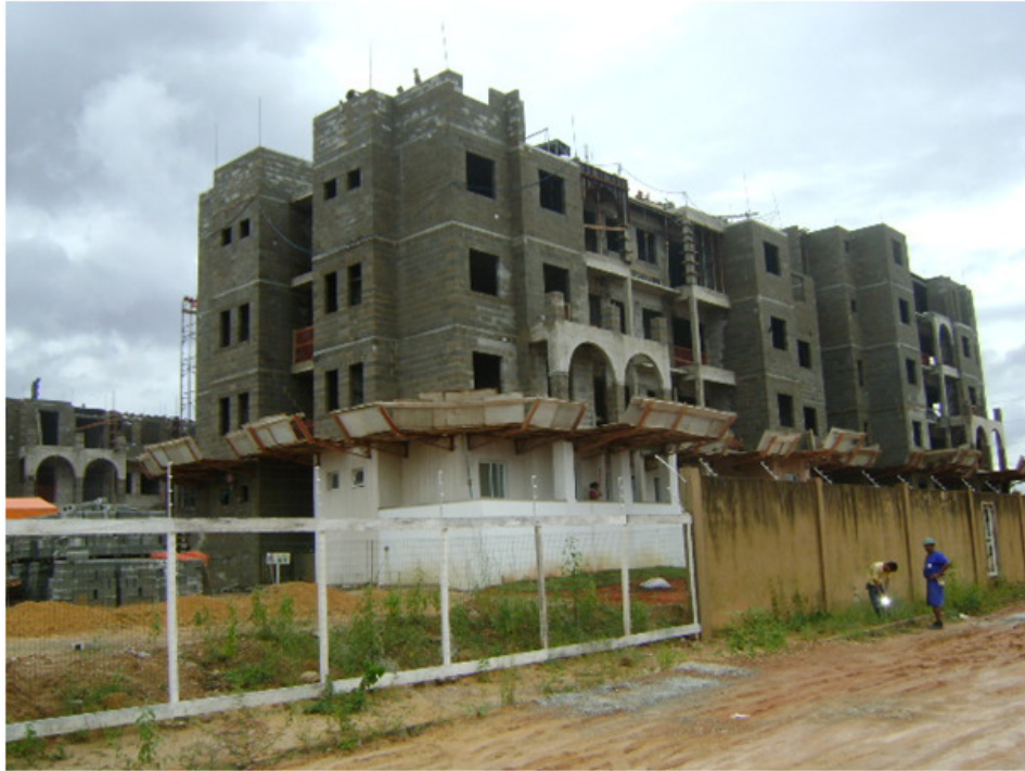
Figura 50 - Protótipo do apartamento modelo aproveitando espaço da obra
