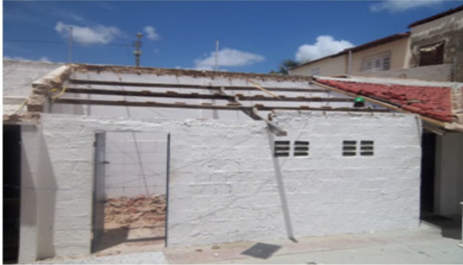
Figura 14 - Aproveitamento de edificação antigo do terreno
