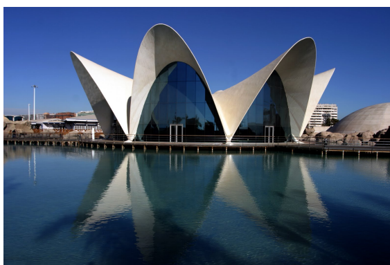
Figura 116 – Estrutura em forma de parabolóide hiperbólico
