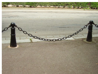
Figura 112 – Catenária formada pela suspensão de uma corrente por dois hastes
