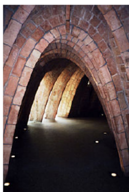
(a) Um túnel
