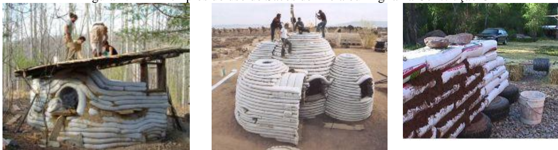
Figura 2.12 – Exemplos do uso de Sacos de Areia ou Argila na Construção Civil
