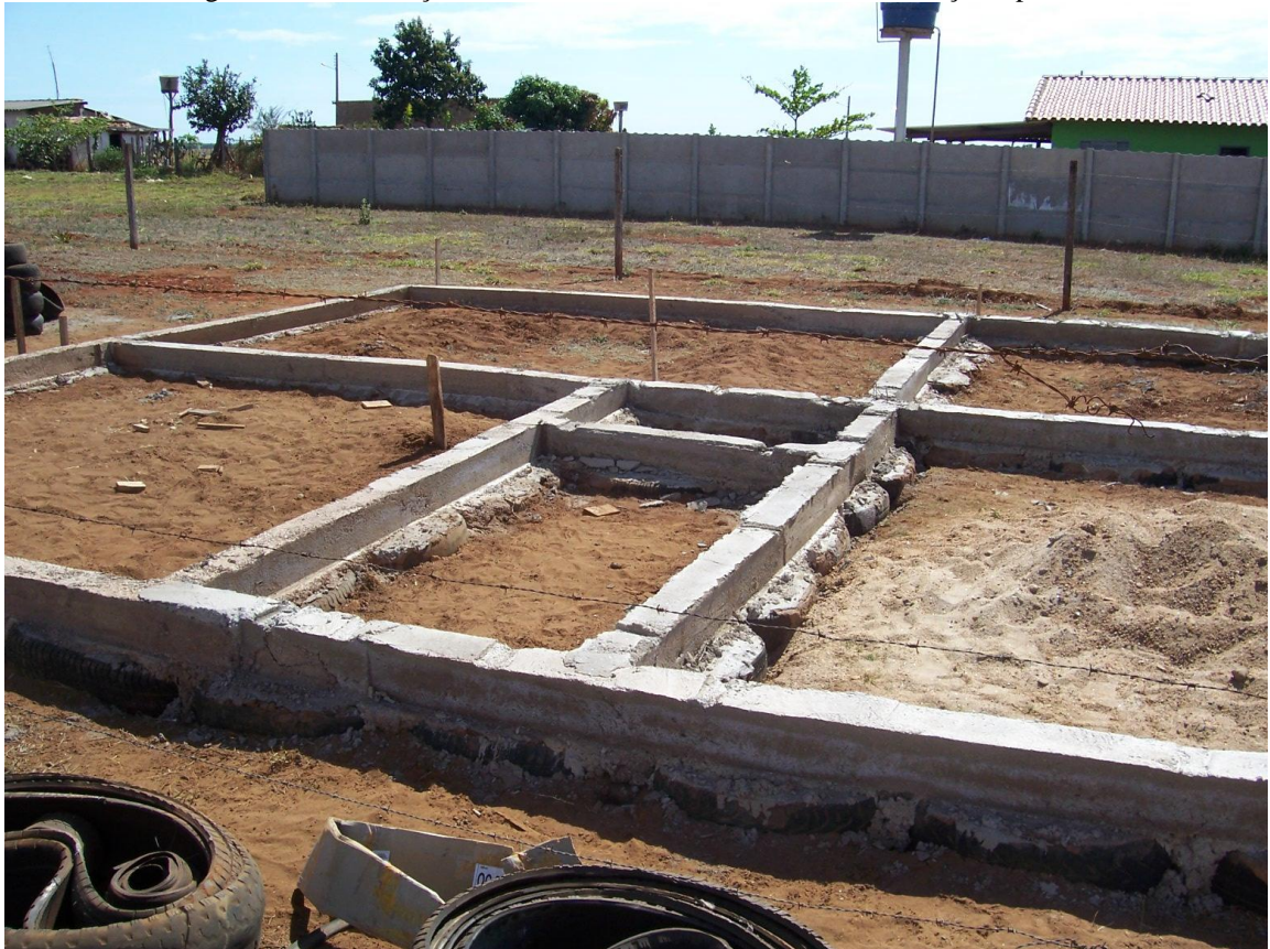
Figura 2.13 – Fundação de uma residência térrea utilizando carcaça de pneus.
