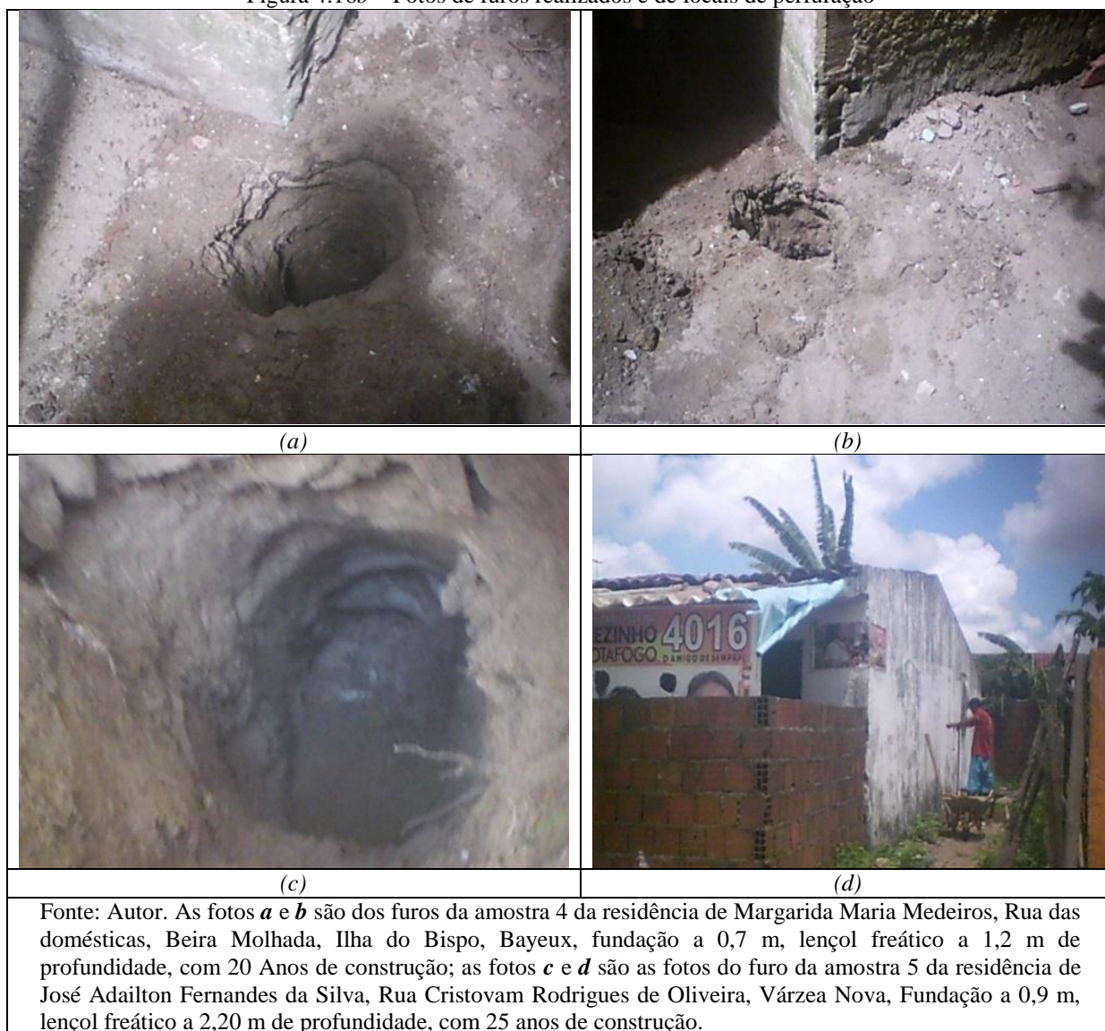
Figura 4.16b – Fotos de furos realizados e de locais de perfuração
