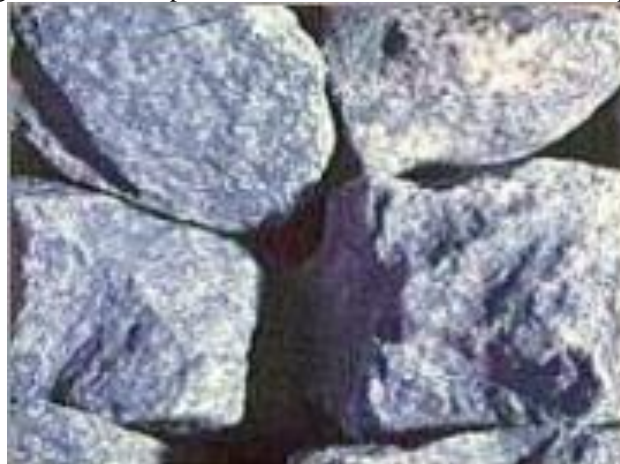
Figura 1.1 – Exemplo de rochas utilizadas em concreto ciclópico
