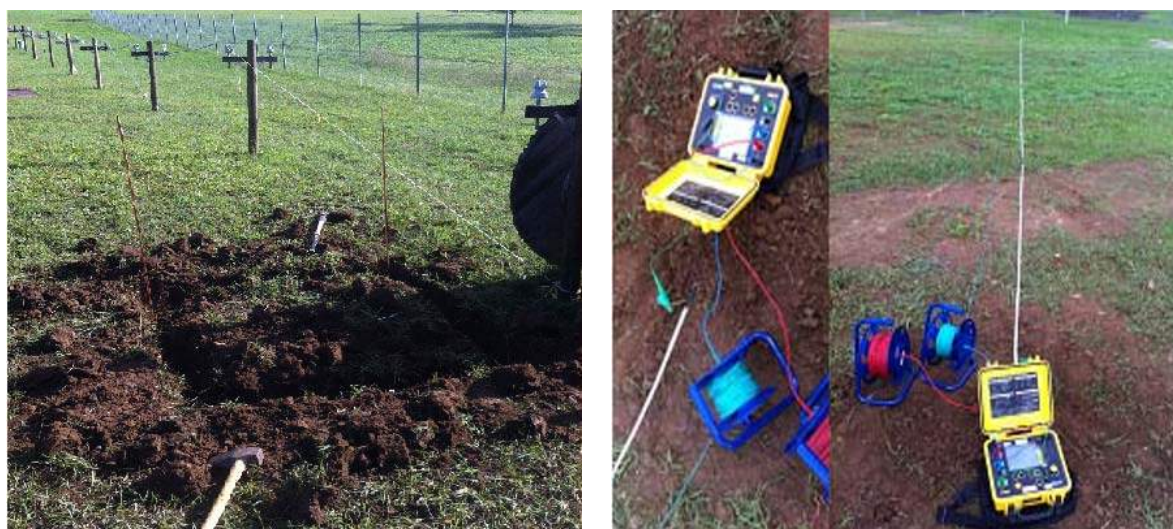
(a) Montagem da malha de aterramento.
