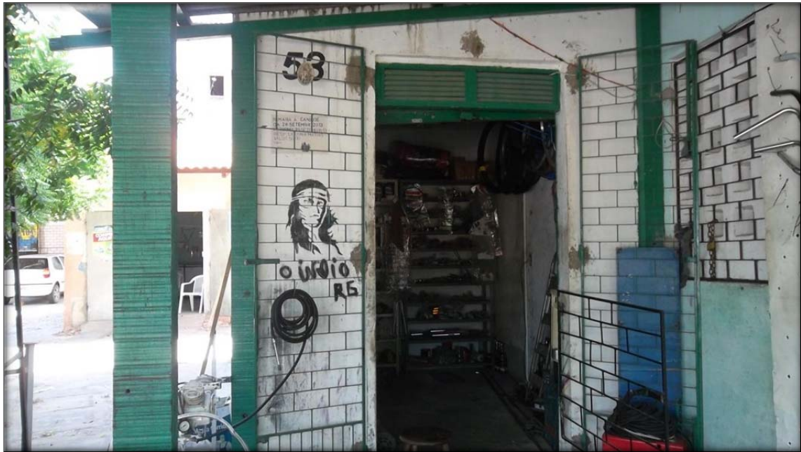
Figura 20 - Quarto de um apartamento adaptado para ser um ponto comercial conjunto habitacional Nossa Senhora de Fátima.
