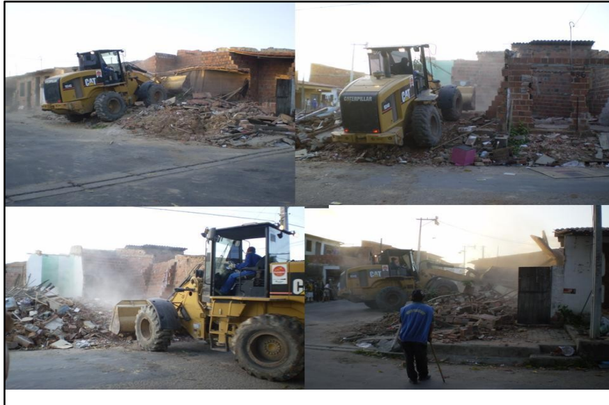
Figura 6 - Demolição de moradias da favela Beira Rio
