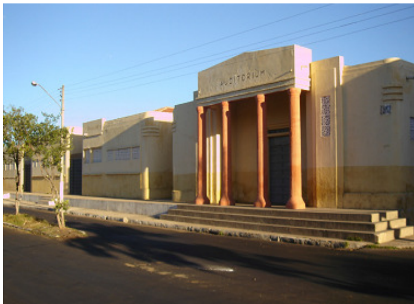
Imagem 10 – Fachada da Escola Normal Rural de Juazeiro do Norte-CE (2010)
