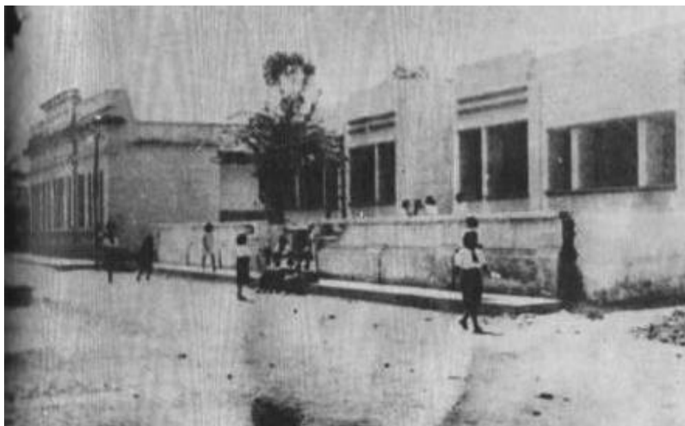
Imagem 9 – Fachada da Escola Normal Rural (1934)
