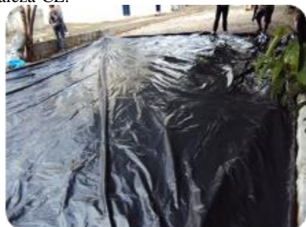
1ª Preparação do terreno
