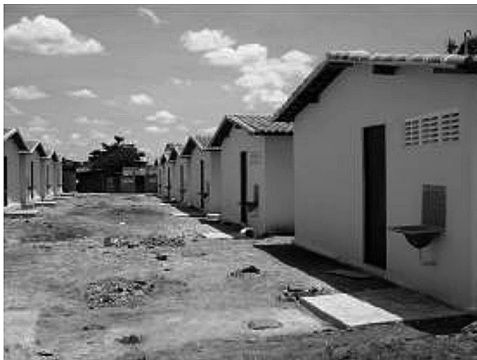
Figura 3 – Pequeno conjunto habitacional destinado às famílias de favela urbanizada
