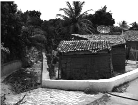
Figura 6 – Favela em área de risco às margens de córrego canalizado
