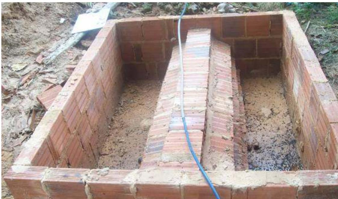
**FIGURA 8:** Sistema de esgoto alternativo (biorremediador) em construção. Fonte: Autora (2008).
