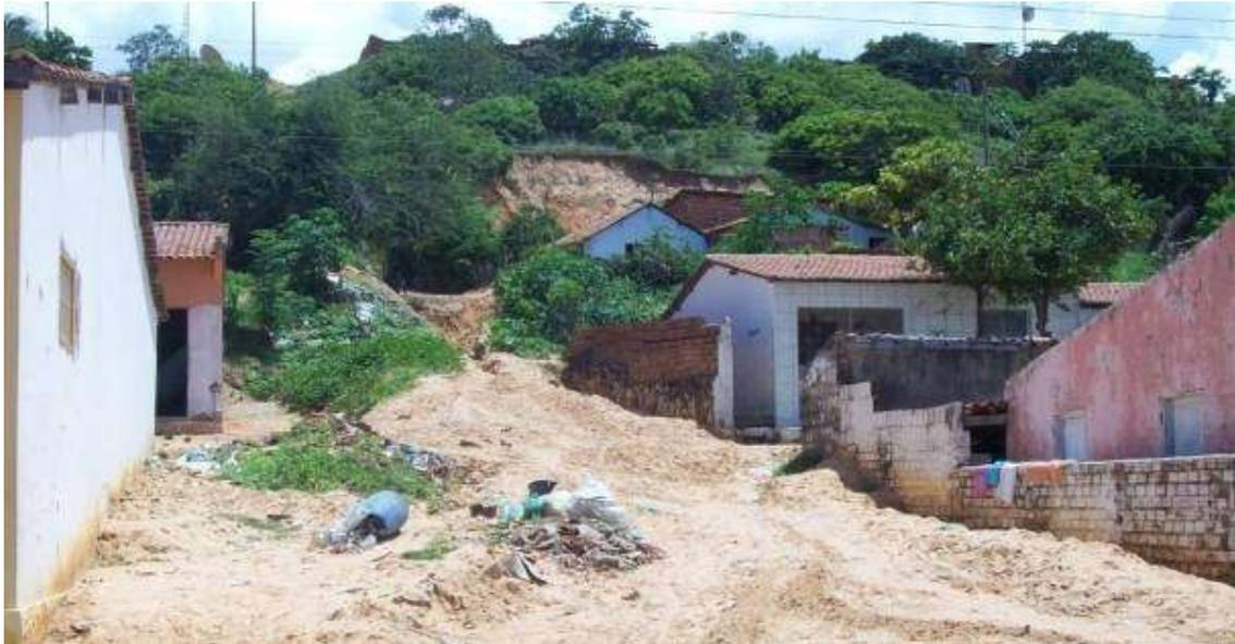
**FIGURA 48:** Construções nas encostas da falésia morta, em Cajuais, acarretando altos índices de erosão. Fonte: Autora (2007).
