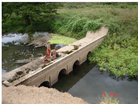
Figura 13. Estrutura de barramento do curso d'água do leito do rio Carás
