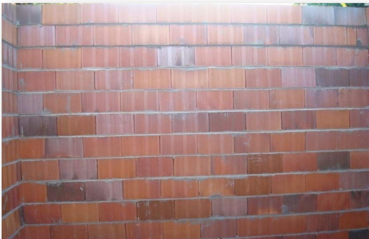
Figura 66 - Detalhe de regularização da junta com boleamento.
