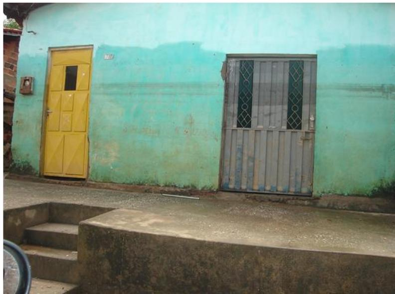
**Figura 18.** Nível alcançado pela água na enchente de maio/2009
