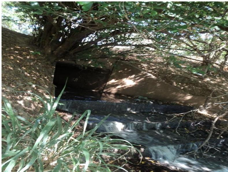
**Figura 15.** Desague no rio Poty da galeria interceptora celular 2,5m x 1,5m, proveniente do bairro Primavera.
