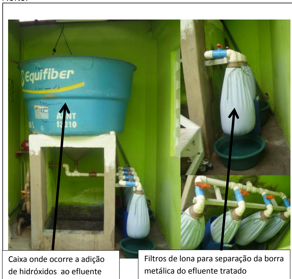
Figura 1 - ETE implantada em indústria de joias folheadas em Juazeiro do Norte.
