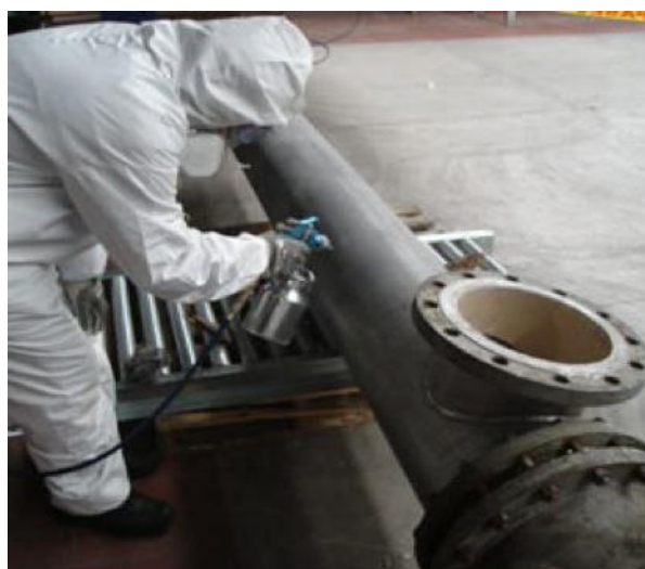
Figura 2.10 - Pintura com tinta de base protetora
