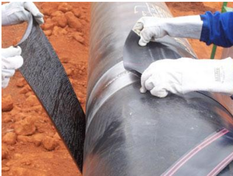
Figura 2.11 - Instalação de fita de revestimento
