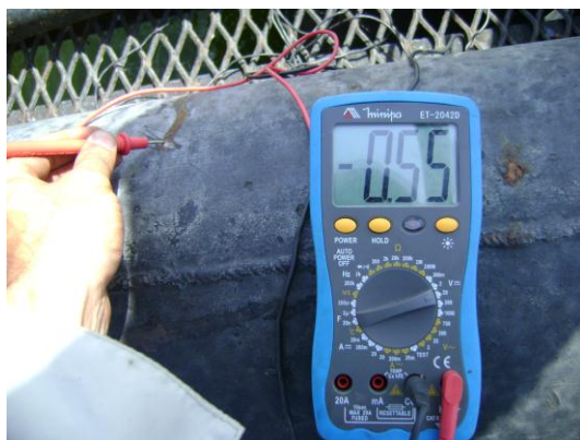
Foto 4.5 - Potencial estrutura/eletrólito sem proteção (-0,55Vcc)
