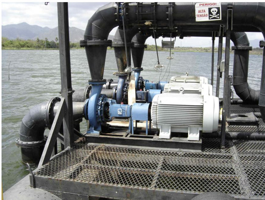
Foto 3.1 - Estrutura metálica a ser protegida
