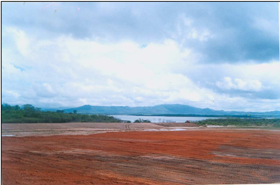
Figura 4.4 - Regularização da superfície topográfica e espalhamento do solo vegetal. Açude Aracoiaba, Ceará. 2007.
