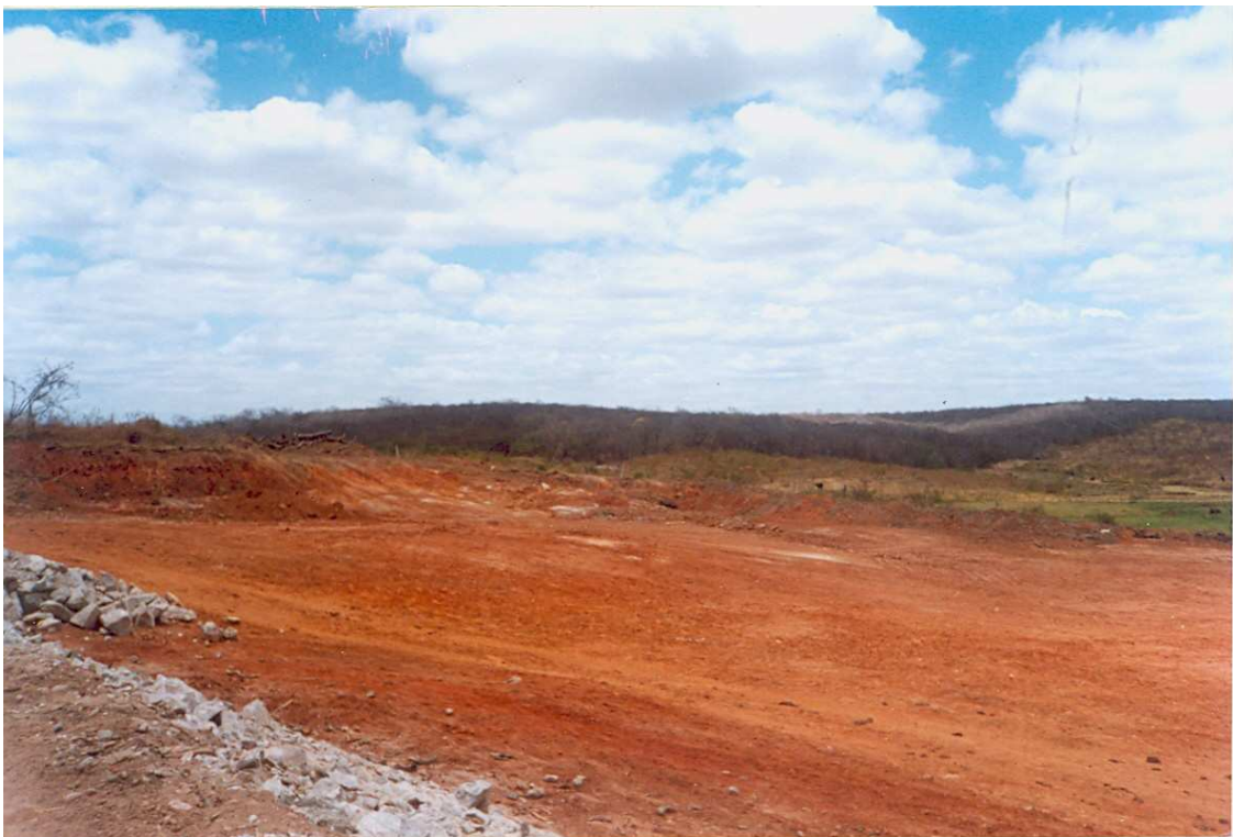
Figura 4.2 – Pilhas de rejeitos. Açude Aracoiaba, Ceará. 2007.
