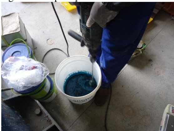
a) mistura dos componentes A e B
