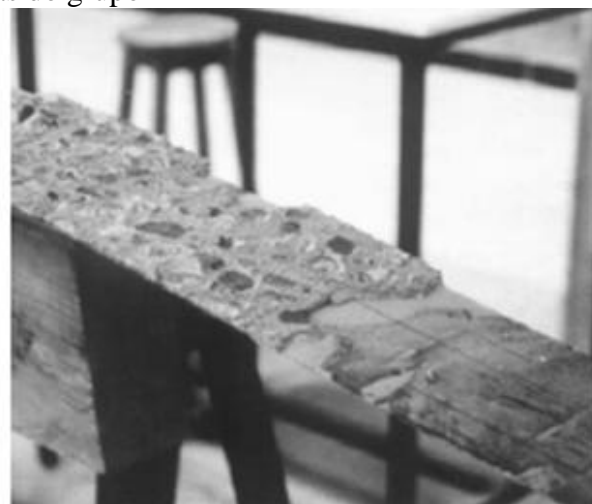
b) concreto aderido ao reforço
