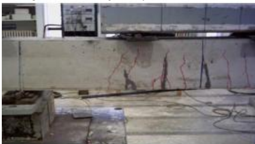
Figura 54 - Detalhe típico da ruína das vigas reforçadas RF
