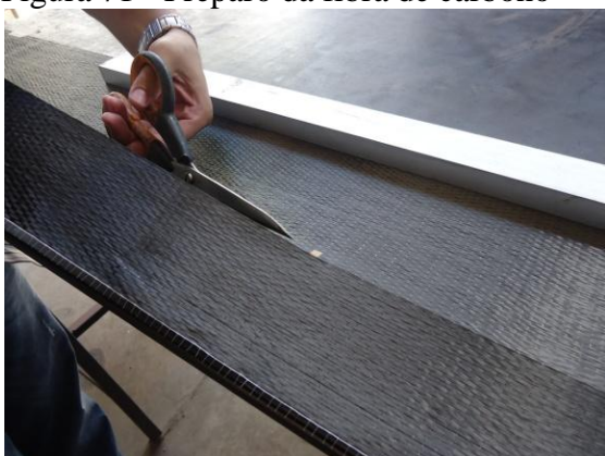
a) corte da manta de fibra de carbono
