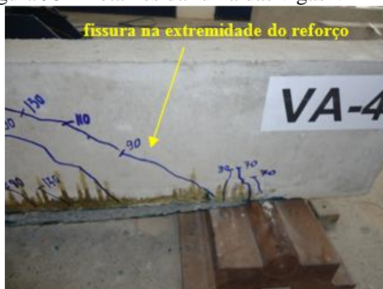
a) fissura na extremidade do reforço (VA-4)
