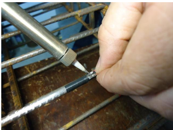
e) soldagem da ligação dos fios
