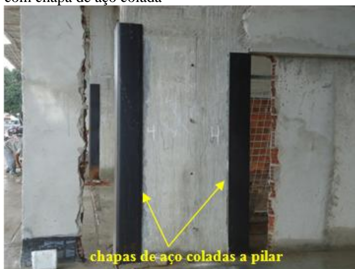
Figura 9 - Reforço com chapa de aço colada
