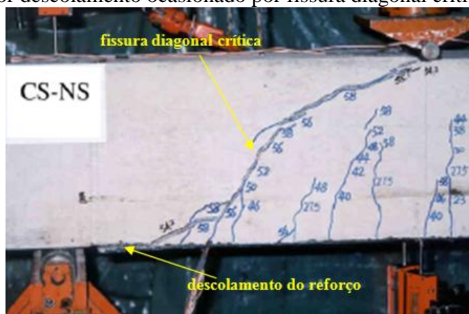
Figura 27 - Ruína por descolamento ocasionado por fissura diagonal crítica
