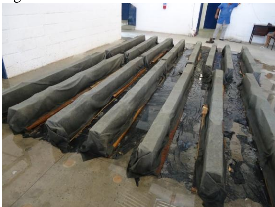
a) vigas em cura úmida
