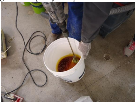
a) mistura dos componentes A e B
