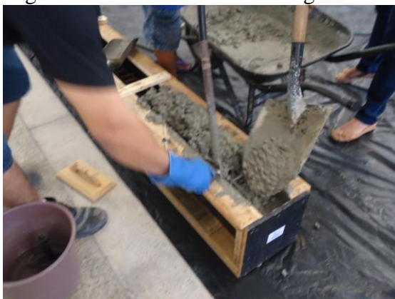
a) lançamento do concreto
