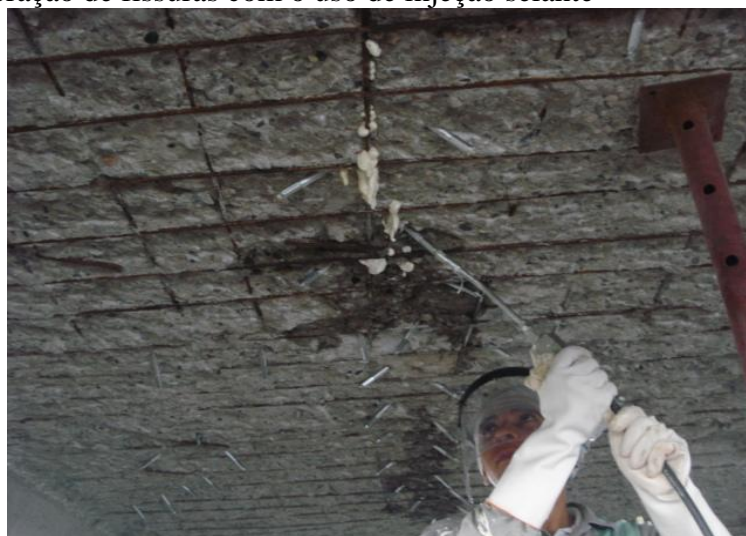
Figura 8 - Recuperação de fissuras com o uso de injeção selante
