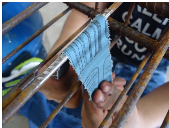
b) lixamento da superfície
