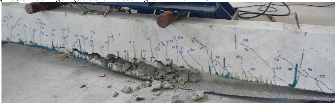
a) configuração da viga VB-4 na ruína
