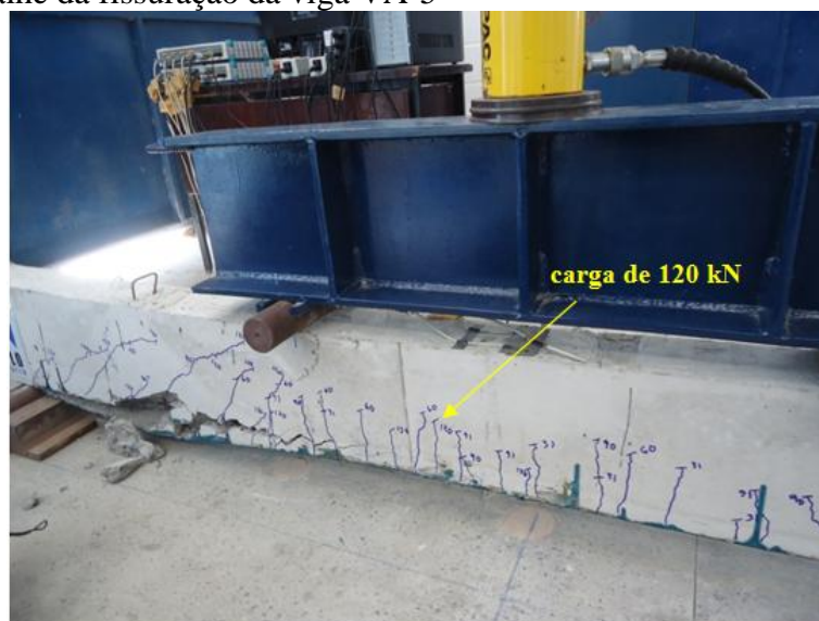
Figura 103 - Detalhe da fissuração da viga VA-5
