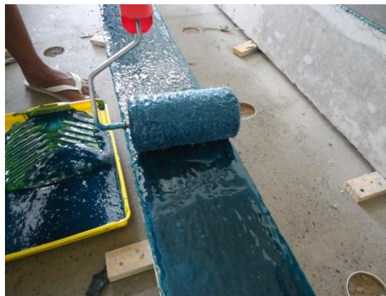
b) aplicação com rolo de espuma
