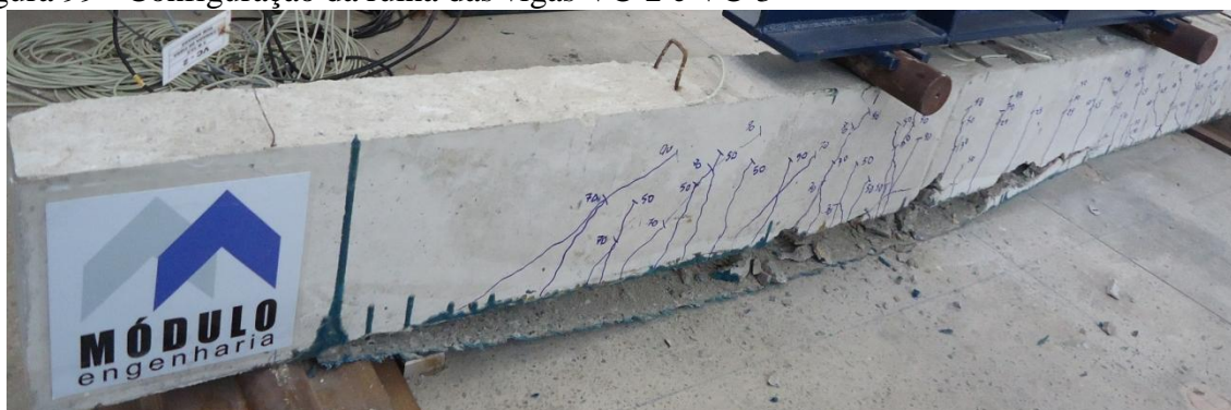
a) configuração da viga VC-2 na ruína
