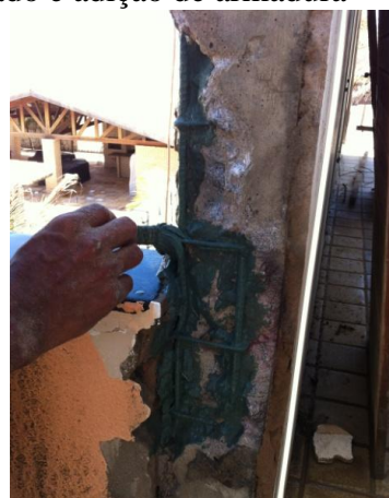
b) pintura da armadura
