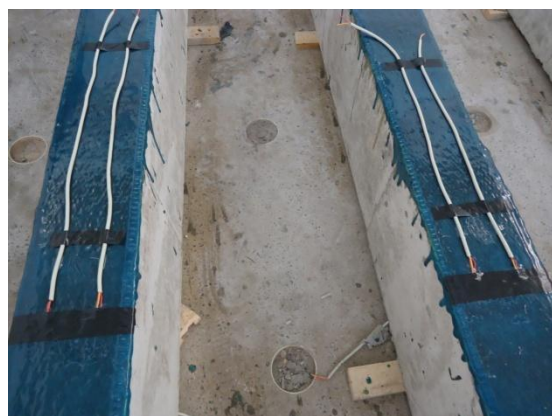
b) proteção com fita isolante
