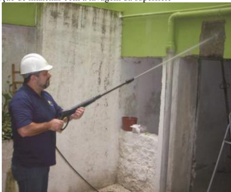
Figura 7 - Remoção de manchas com a lavagem da superfície
