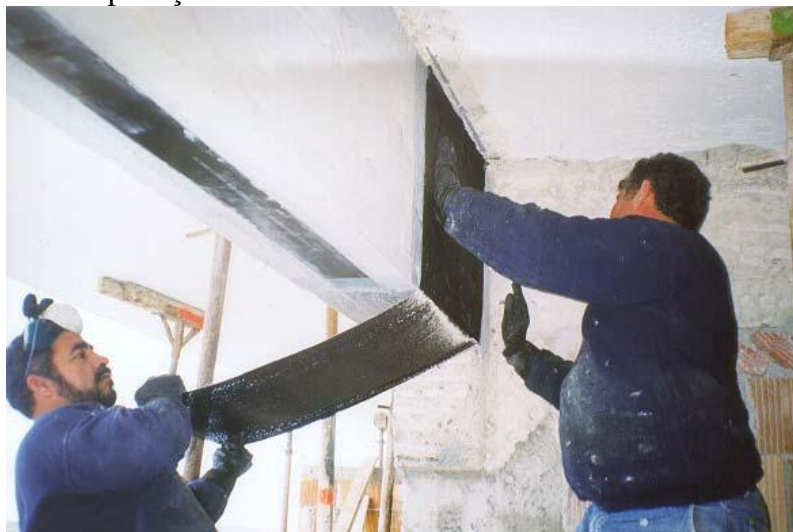
Figura 18 - Detalhe da aplicação de manta de fibra de carbono
