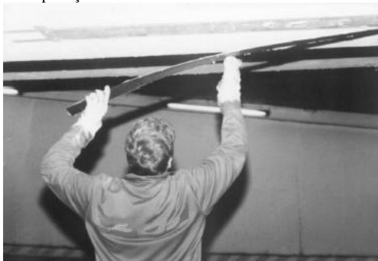
Figura 17 - Detalhe da aplicação de laminado em estrutura de concreto
