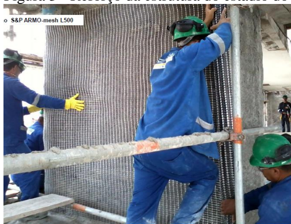
a) reforço nos pilares
