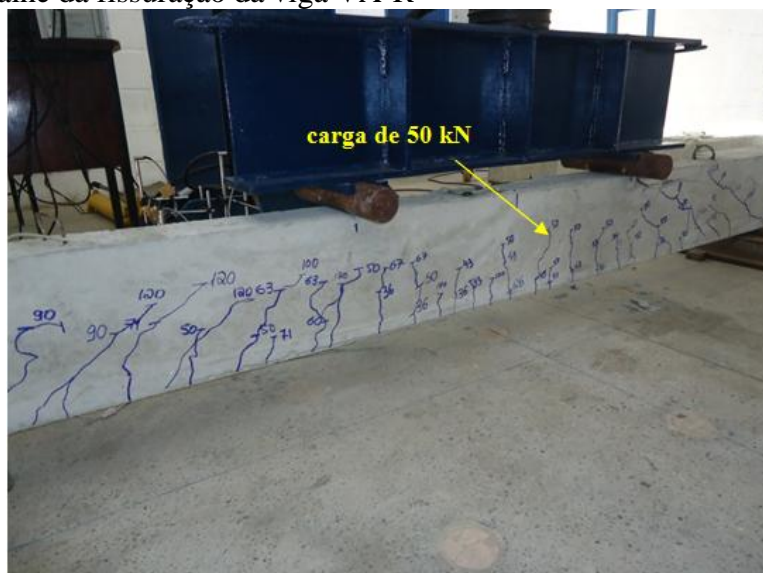
Figura 102 - Detalhe da fissuração da viga VA-R
