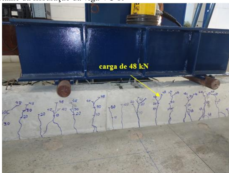
Figura 106 - Detalhe da fissuração da viga VC-R
