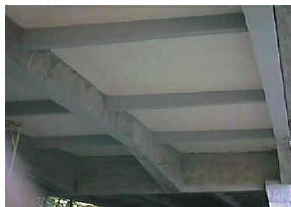
c) aspecto após a conclusão dos serviços de reforço
