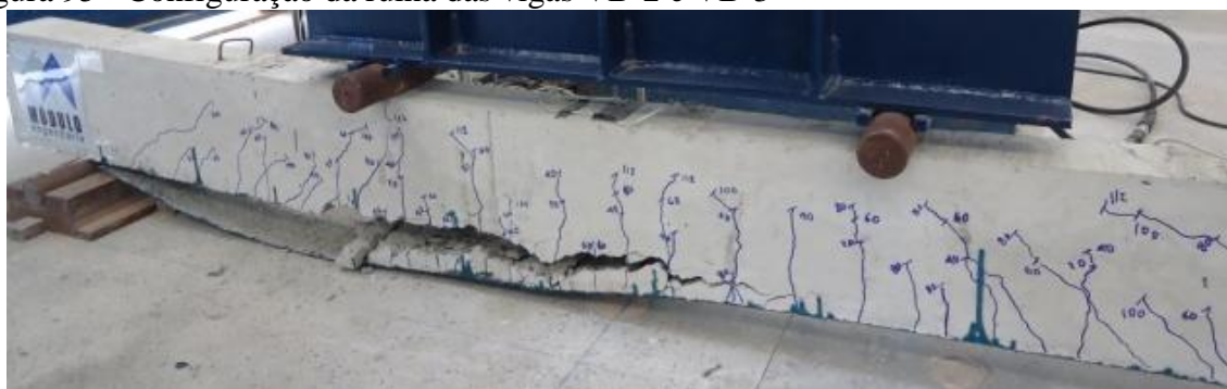
a) configuração da viga VB-2 na ruína
