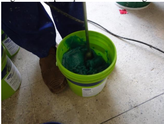
a) mistura dos componentes A e B
