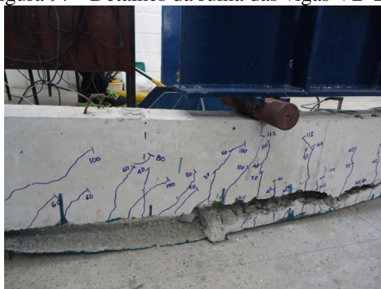
a) fissura na extremidade do reforço (VB-2)
