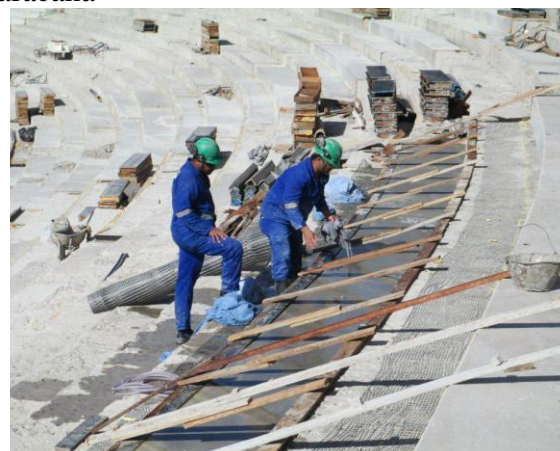
b) reforço na arquibancada
