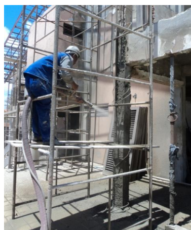
c) projeção do concreto
