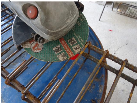
a) desbaste das nervuras
