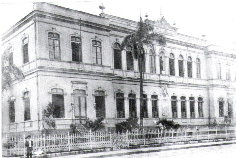
Foto 3.7: Escola Rivadávia Corrêa, atual Centro de Referência da Educação Pública da Cidade do Rio de Janeiro
