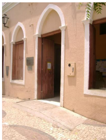
Foto 5.76: Fachada principal – entrada com rampa Fonte: foto da autora, 2010
