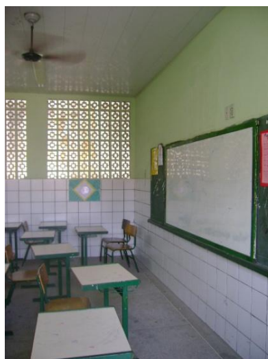
Foto 5.71: Sala de aula – janelas substituídas por cobogós Fonte: Foto da autora, 2010
