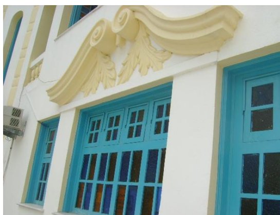
Foto 5.153: Detalhe de volutas e esquadrias Fonte: Foto da autora, 2009
