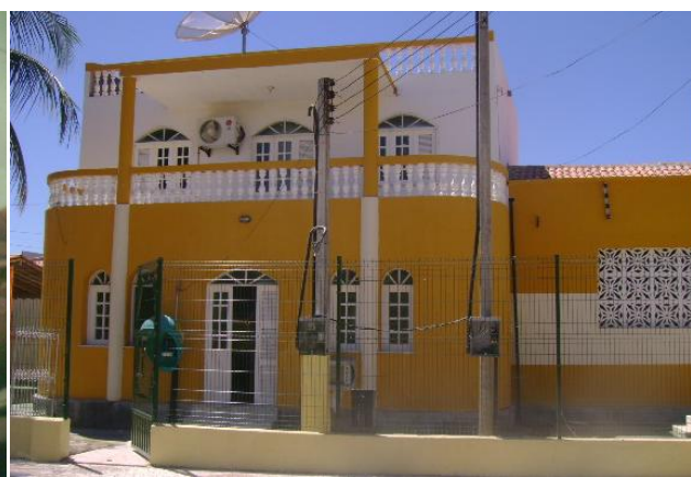
Foto 5.84: Fachada principal, com pav. superior. Fonte: foto da autora, 2010
