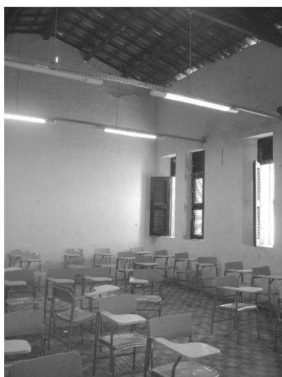
Foto 5.60: Sala de aula do bloco original Fonte: foto da autora, 2010
