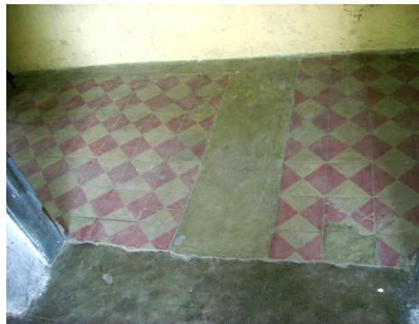
Foto 5.38: Detalhe do piso onde existia parede Fonte: foto da autora, 2008
