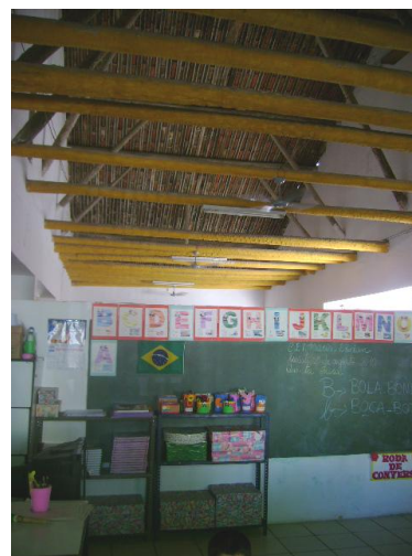
Foto 5.49: Vista interna ex-Grupo Escolar de Aracati – com visão da estrutura em carnaúba e coberta. Fonte: foto da autora, 2010
