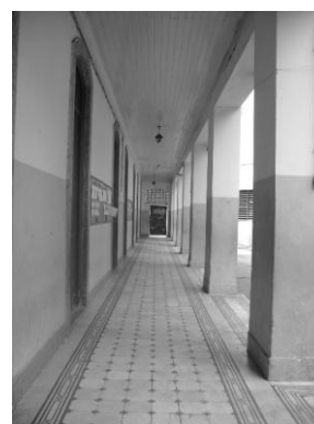
Foto 3.17: Detalhe piso da circulação externa em ladrilho hidráulico - Escola Soares Pereira, Tijuca, Rio de Janeiro Fonte: Foto da autora, 2010
