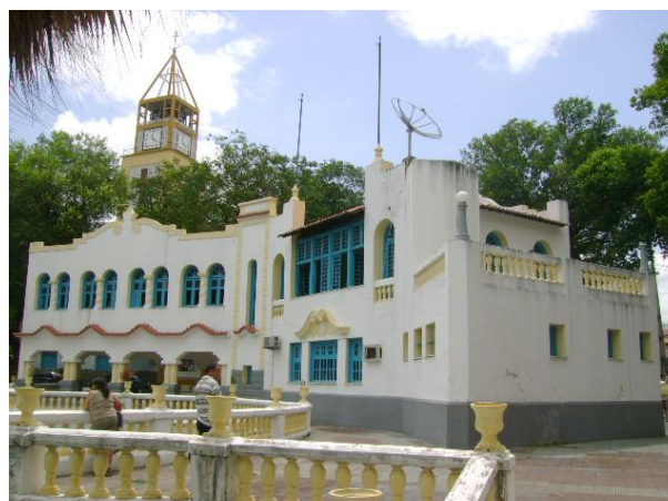
Foto 5.149: Edificações do Serviço de Educação Infantil – vista do terraço Fonte: Foto da autora, 2009
