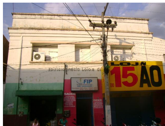
Foto 5.91: Fachada principal prédio ex-Grupo Cratense Fonte: foto da autora, 2010
