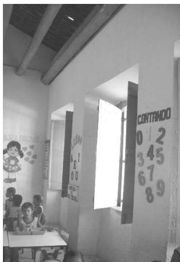
Foto 5.54: Vista interna do ex-Grupo Escolar de Aracati – sala de aula atual creche escola.
