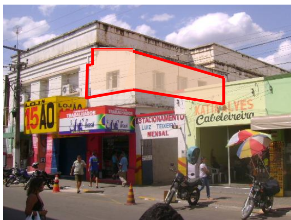
Foto 5.90: Vista geral prédio Ex-Grupo Cratense Fonte: foto da autora, 2010
