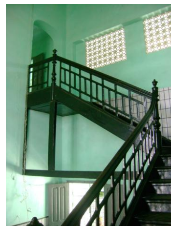
Foto 5.20: Escada - E.E.F.M. Visconde do Rio Branco Fonte: Foto da autora, 2009
