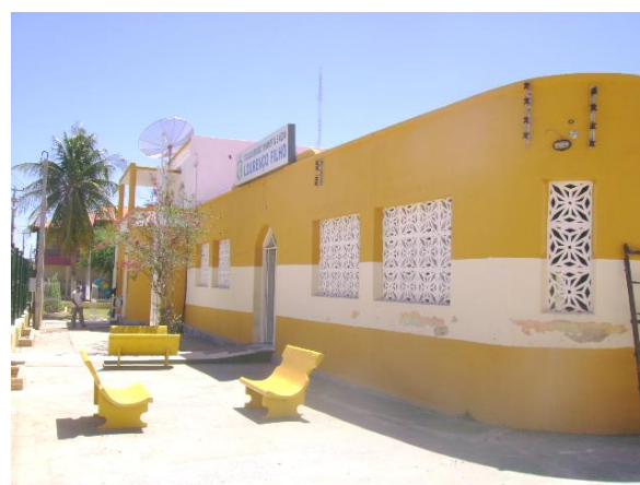
Foto 5.88: Vista Externa - Pátio de entrada Fonte: foto da autora, 2010
