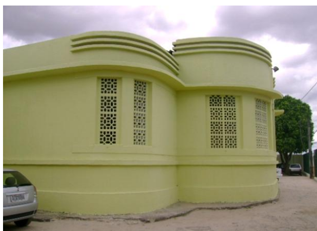
Foto 5.137: Fachada descaracterizada pelo fechamento externo das janelas com cobogó. Fonte: foto da autora, 2009
