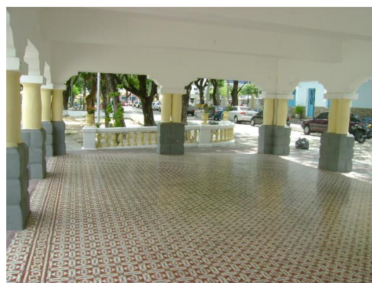
Foto 5.154: Vista interna pilotis – detalhe do piso em ladrilho hidráulico Fonte: Foto da autora, 2009
