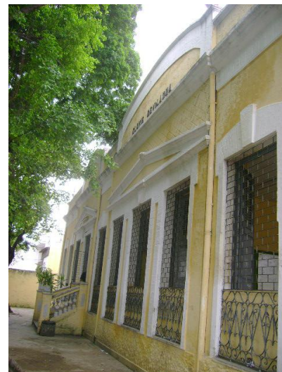
Foto 5.33: Fachada principal (atual) Fonte: arquivo pessoal autora, 2008
