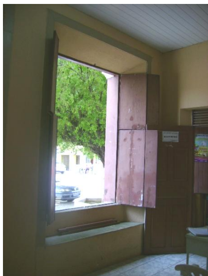
Foto 5.79: Detalhe da janela – vista interna. Fonte: foto da autora, 2010
