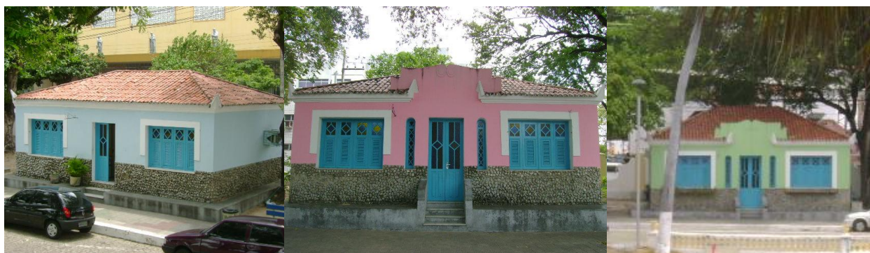
Foto 5.150: Edificações do Serviço de Educação Infantil – sala de aula Fonte: Foto da autora, 2009
