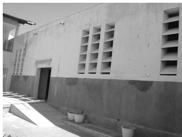
Foto 5.112 Vista acesso – Ex-Grupo Escolar de Quixadá
