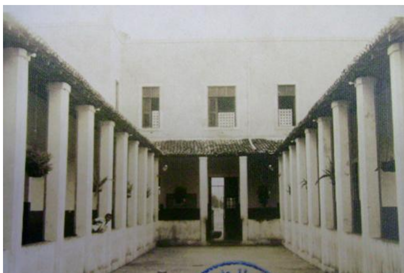
Foto 5.128: Vista pátio central Grupo Escolar Prof. Arruda. Fonte: Acervo da Escola, 1975
