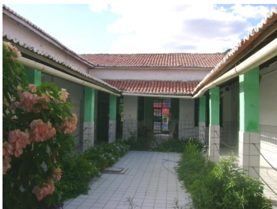
Foto 5.115: Vista pátio central original EEFM José Jucá.
