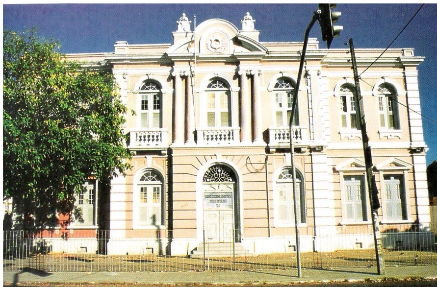
Foto 5.42: Grupo Escolar Rodolfo Teófilo – atual Faculdade de Economia, Administração, Atuária e Contabilidade (FEAAC)/UFC Fonte: Cals, 2000.
