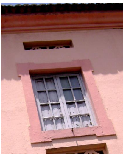
Foto 5.26: Janela original – vista externa E.E.F.M. Juvenal Galeno Fonte: Foto da autora, 2008
