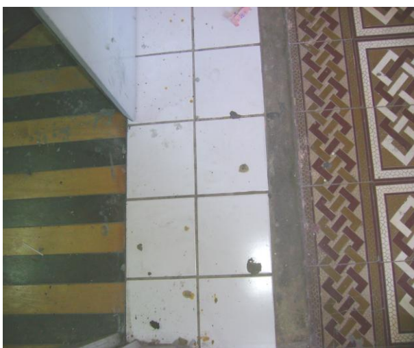
Foto 5.30: Piso em madeira ainda existente no almoxarifado e circulação em ladrilho hidráulico no pavimento superior Fonte: Foto da autora, 2008
