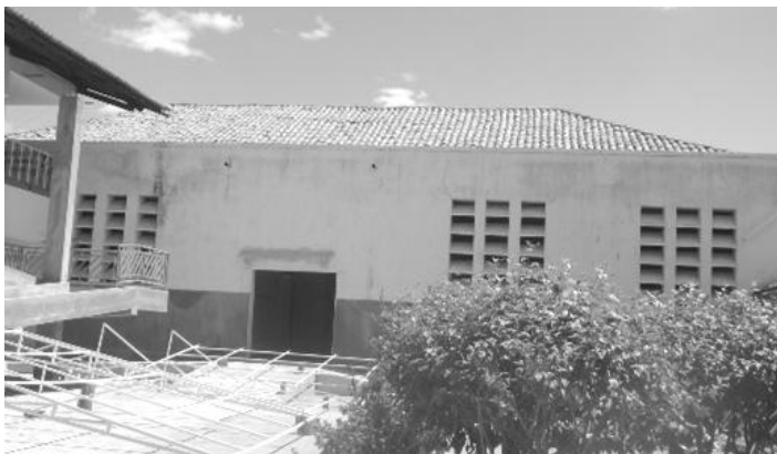
Foto 5.109: Grupo Escolar de Quixadá (2ª instalação)
