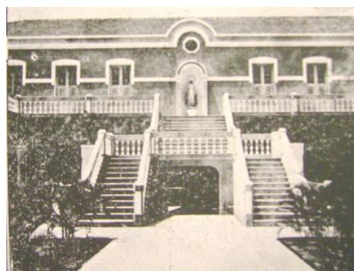
Foto 4.15: Escadaria e pátio interno do Colégio da Imaculada Conceição
