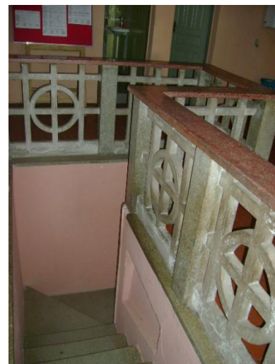
Foto 5.94: Acesso ao pavimento superior Fonte: foto da autora, 2010
