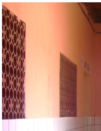
Foto 5.27: Janelas substituídas por cobogós E.E.F.M. Juvenal Galeno Fonte: Foto da autora, 2008
