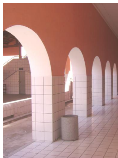
Foto 5.31: Circulação pavimento térreo – piso substituído por cerâmica Fonte: Foto da autora, 2008
