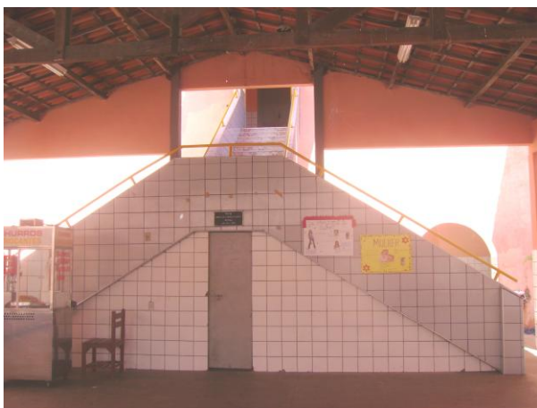
Foto 5.28: Escada em concreto revestida de cerâmica Fonte: Foto da autora, 2008
