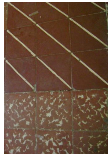
Foto 5.53B: Vista interna do ex-Grupo Escolar de Aracati – piso das salas de aula em ladrilho hidráulico. Fonte: foto da autora, 2010
