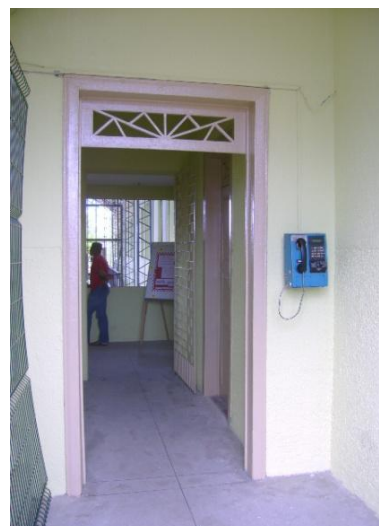
Foto 5.140: Detalhe original da bandeira da porta com elementos geométricos vazados Fonte: foto da autora, 2009
