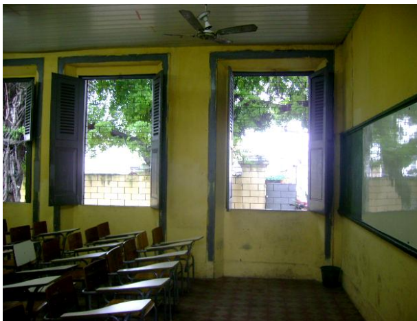
Foto 5.37: Vista da sala de aula com antigas portas-balcão, fechadas na parte inferior. Fonte: foto da autora, 2008
