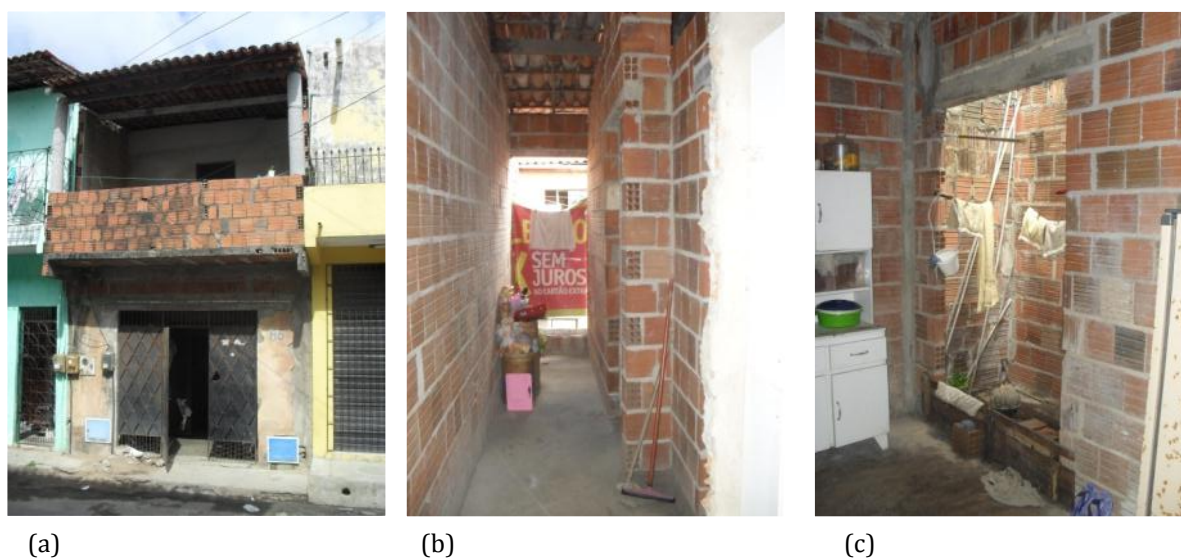
Figura 40: Registro fotográfico da UH 2621. (a) Fachada; (b) Circulação do pavimento superior em direção a laje no fundo; (c) Refeições e área livre no pavimento térreo.
