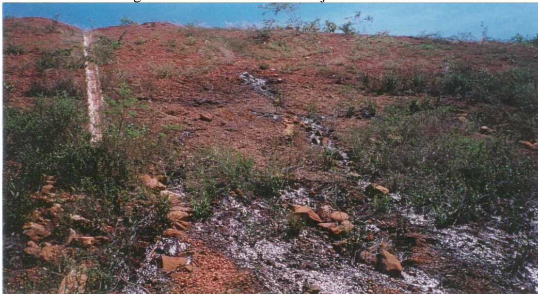
Figura 3.23 - Vista do talude de jusante saturado
