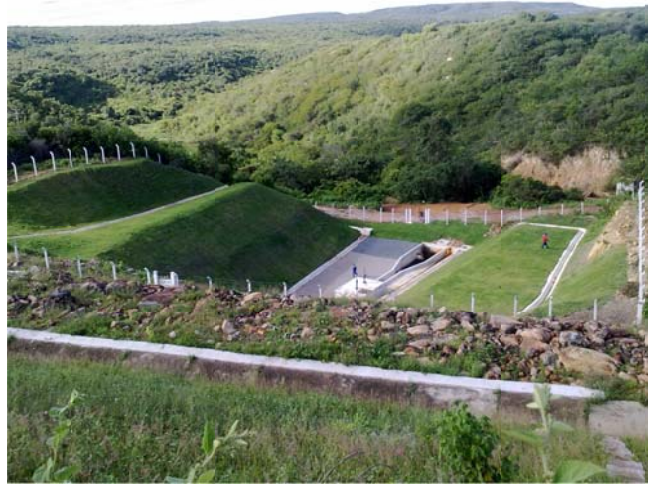
Fonte: Cogeh (2011). Foto da Inspeção realizada em 04/03/2011
