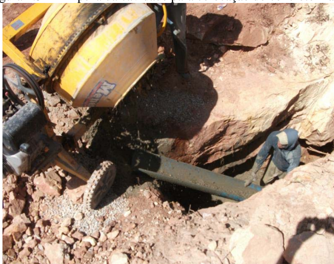
Figura 4.5 – Limpeza da cavidade para colocação do concreto magro
