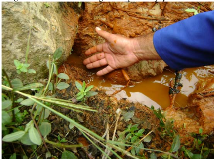
Figura 4.4 - Detalhe da surgência após a injeção de asfalto
