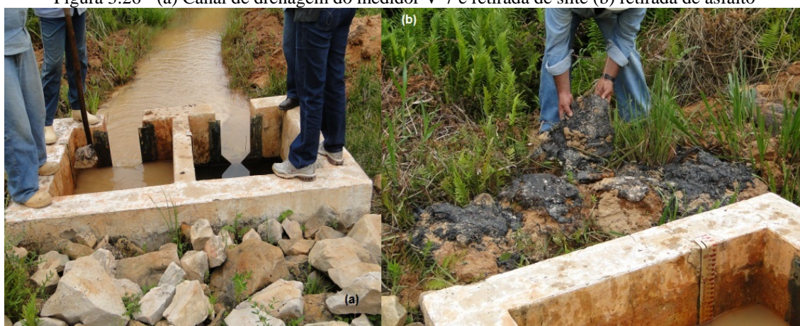
Figura 3.26 - (a) Canal de drenagem do medidor V-7 e retirada de silte (b) retirada de asfalto
