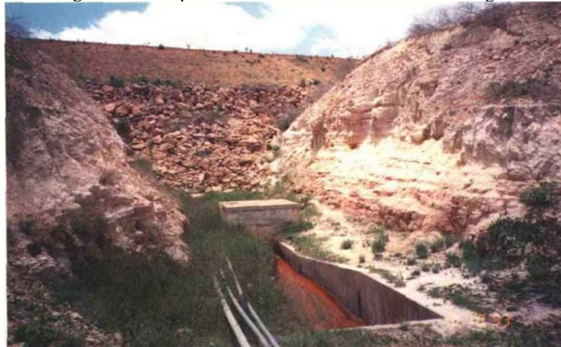
Figura 3.22 - Aspecto da rocha no canal da Tomada de Água
