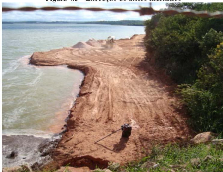
Figura 4.3 - Execução do aterro hidráulico
