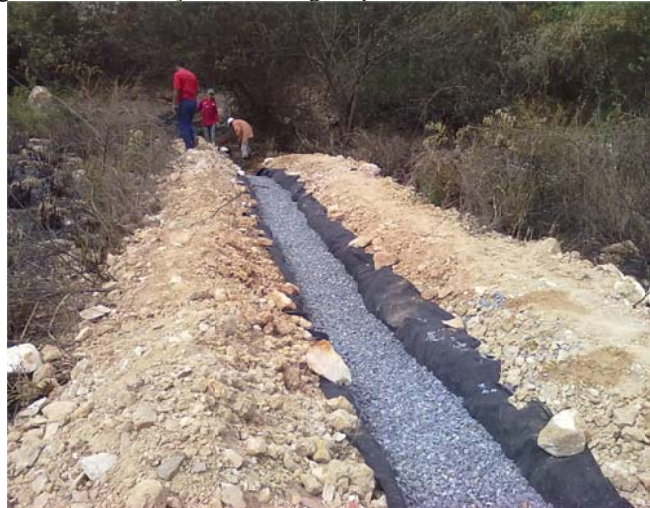
Figura 4.7 - Execução da drenagem para o medidor de vazão V-05
