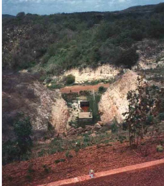
Fonte: Cogeh (2001). Foto de inspeção
