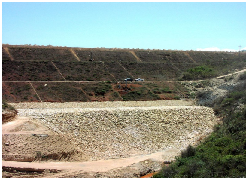
Fonte: Cogeh (2004) Relatório dos Serviços de Supervisão e Acompanhamento da Execução das obras de Recuperação da Barragem Jaburu
