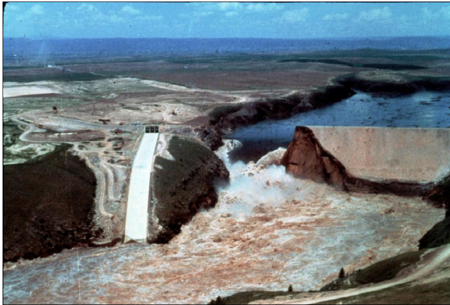
Figura 17 - O rompimento de Teton Dam
