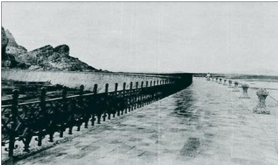
Figura 23 - Vista da construção do Açude Cedro, no ano de sua inauguração, 1906, Quixadá, Ceará
