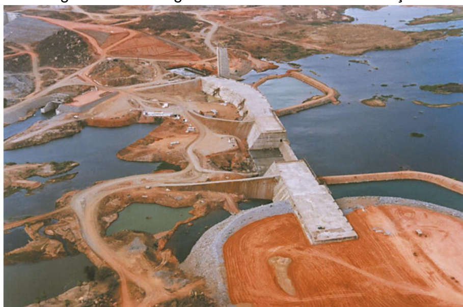
Figura 34 – Barragem do Castanhão em construção
