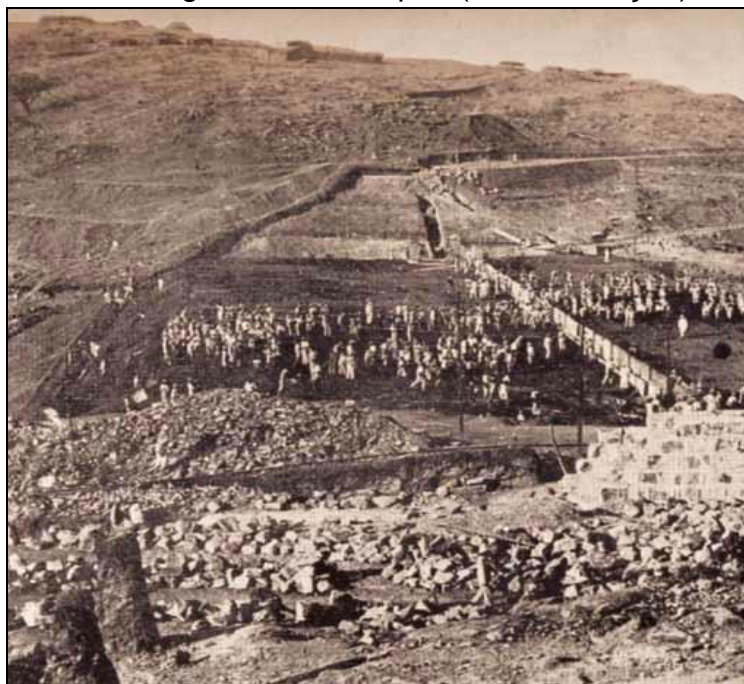
Figura 31 - Barragem Lima Campos (em construção) em 1932
