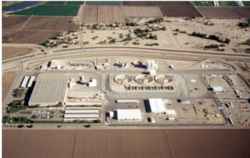
Figura 20 - Vista aérea do Complexo de Dessalinização de Yuma.
