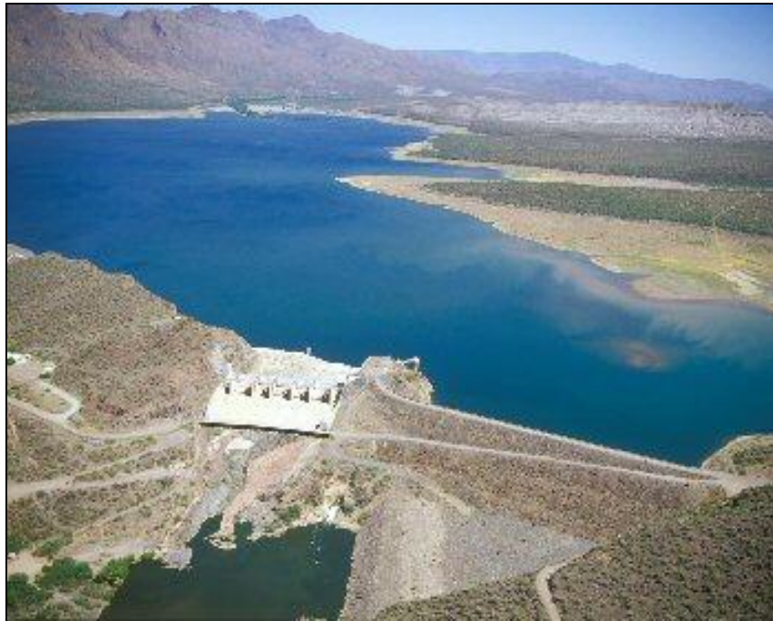
Figura 10 - A Barragem Horseshoe e seu reservatório – construída de 1944 a 1946
