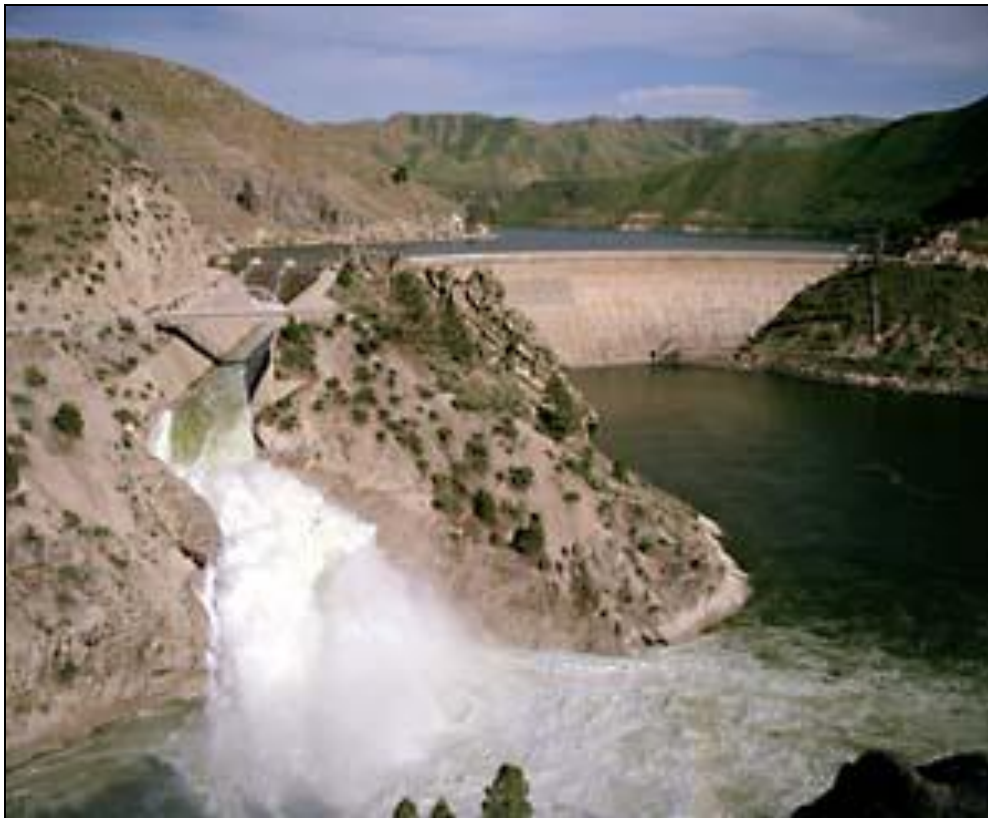
Figura 6 - Vista da Barragem Arrowrock construída em 1915 pelo USBR
