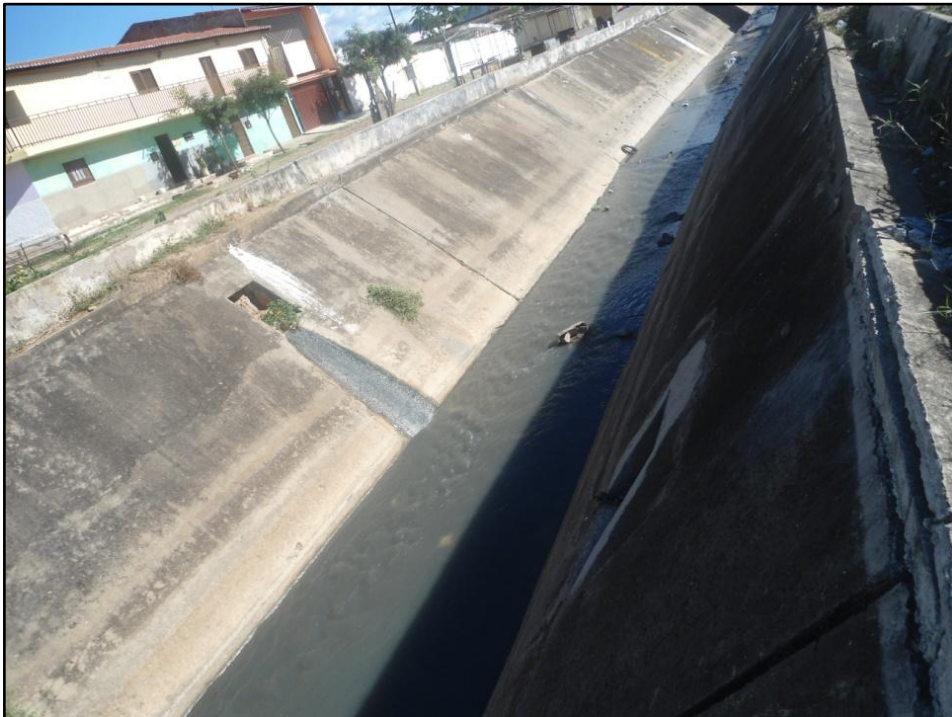
Figura 13: Perfil longitudinal do canal do Rio granjeiro
