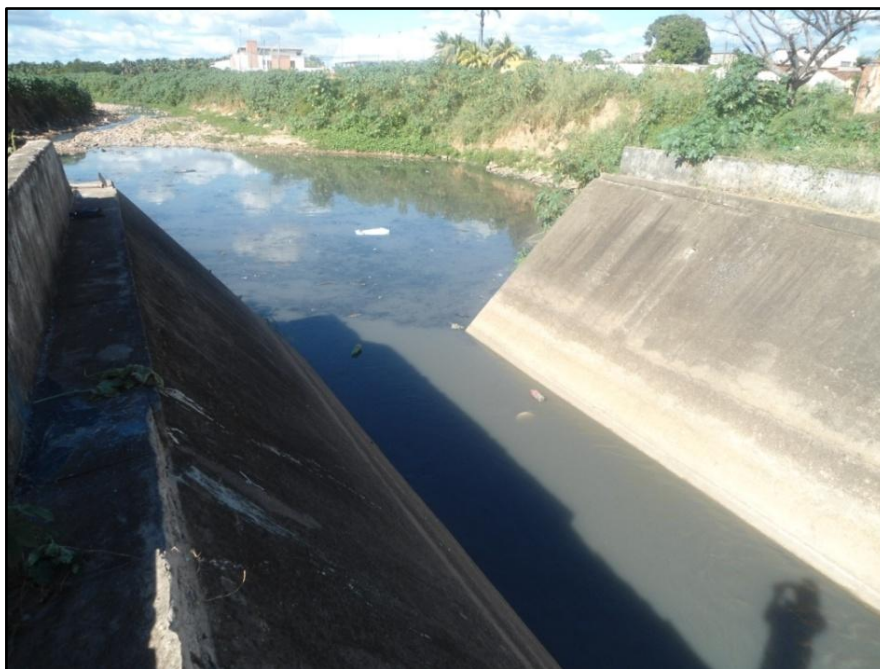
Figura 16: Vista da seção final do canal do Rio Granjeiro
