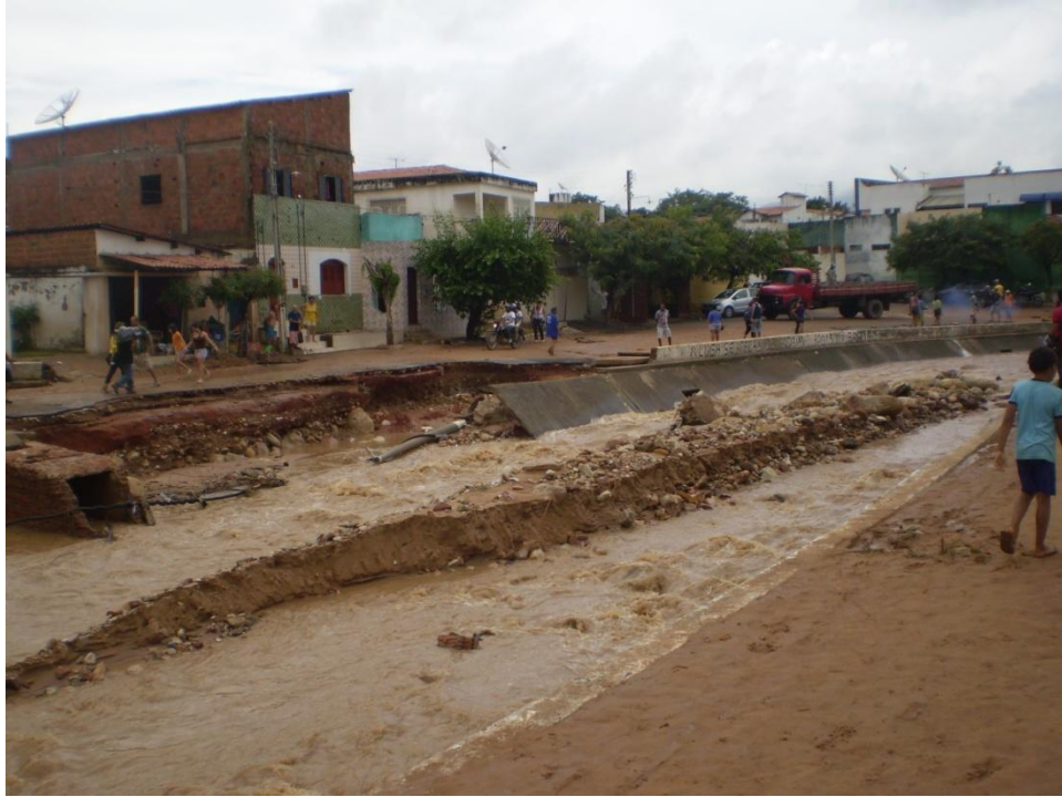
Figura 01: Transbordamento de trecho do canal do Rio Granjeiro. (Fonte: Autor)
