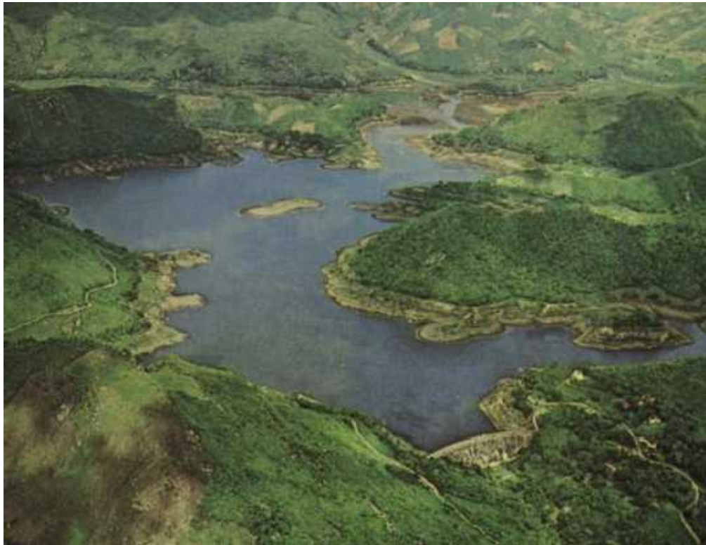
Figura 4.20 - Açude Acarape do Meio
