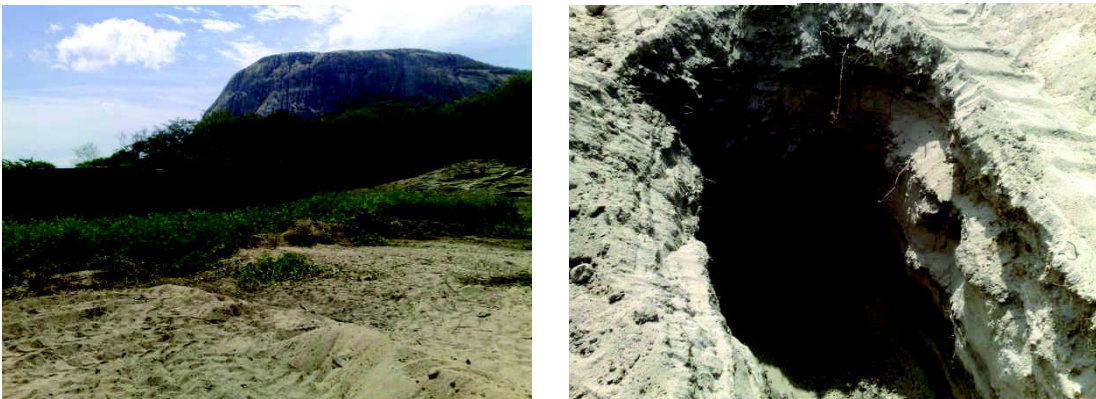
Figura 27 - Material do lado montante da barragem construída
