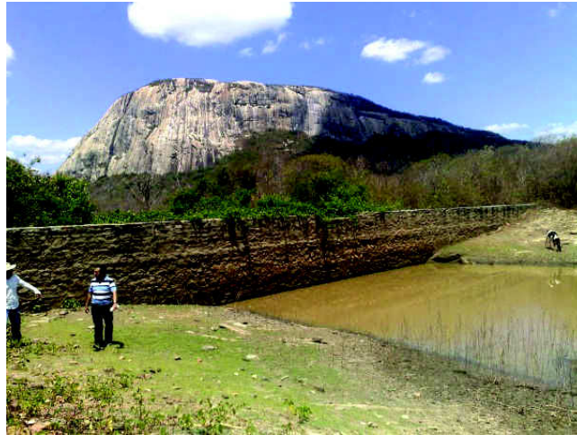
Figura 22 - Barragem existente de alvenaria de pedra
