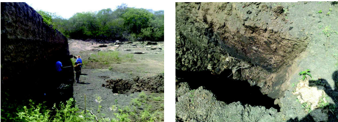
Figura 28 - Material do lado jusante da barragem de terra construída
