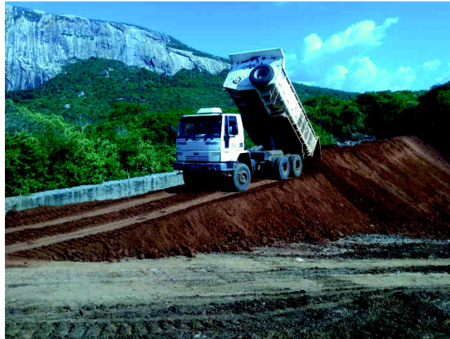
Figura 23 - Barragem de Terra em fase de construção
