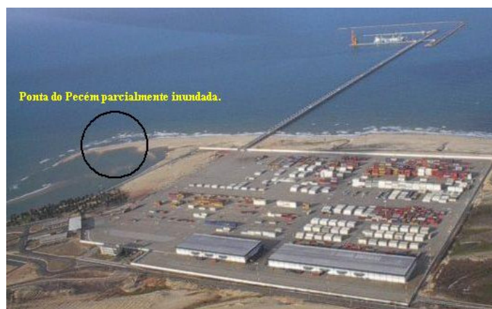
Figura 5 – Ponta do Pecém parcialmente inundada na preamar.
