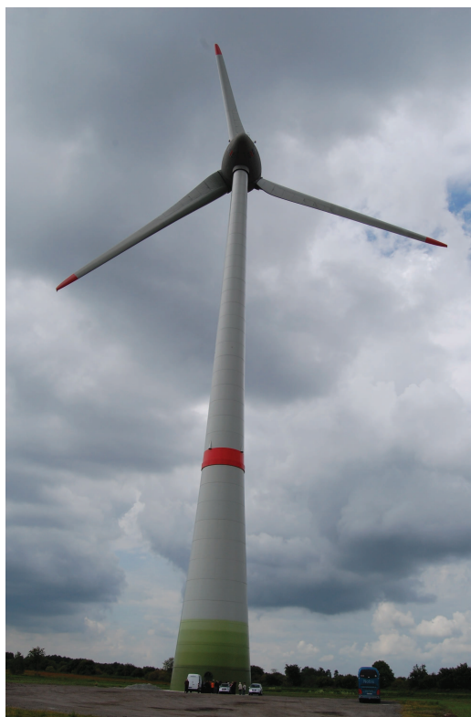
Figura 1.4: Turbina Enercon E-126
