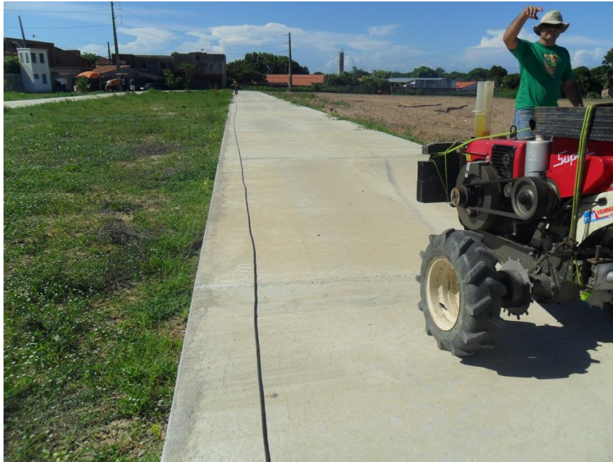
Figura 3 – Vista da pista de concreto
