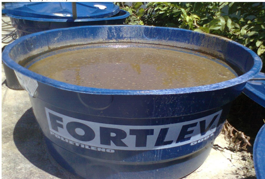
Figura 7 – Caixas de polietileno, com capacidade de 500 L, Redenção, Ceará, 2014
