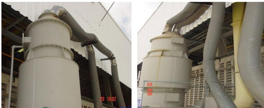
**Fotos 15 e 16 - Planta dos inseticidas com sistemas abatedores de gases com possibilidades de emissões fugitivas através da tubulação.**
