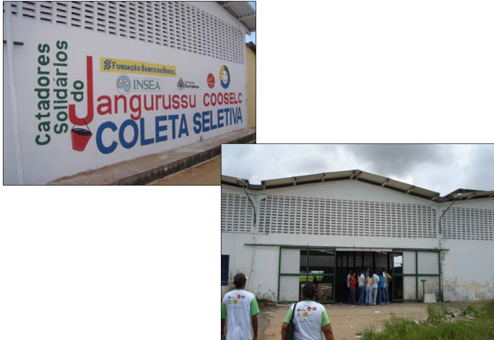
Figura 18 - Vista Frontal do Galpão da ASCAJAN. Foto do Autor (2008).
