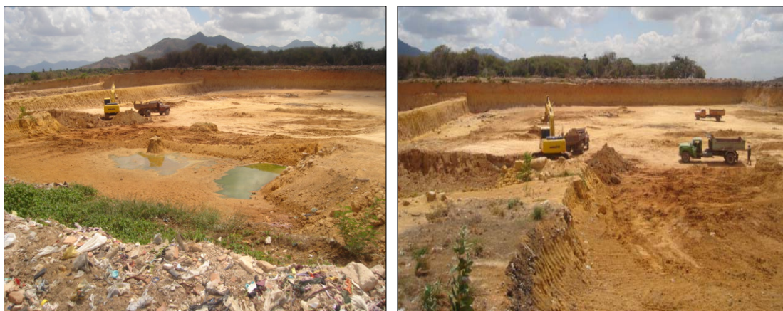
Figura 16 - Células Abertas para Compactação do RSD no ASMOC.
