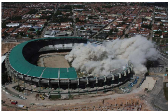
Figura 06: Implosão trecho da arquibancada do Estádio Castelão (Fonte: SETUR)
