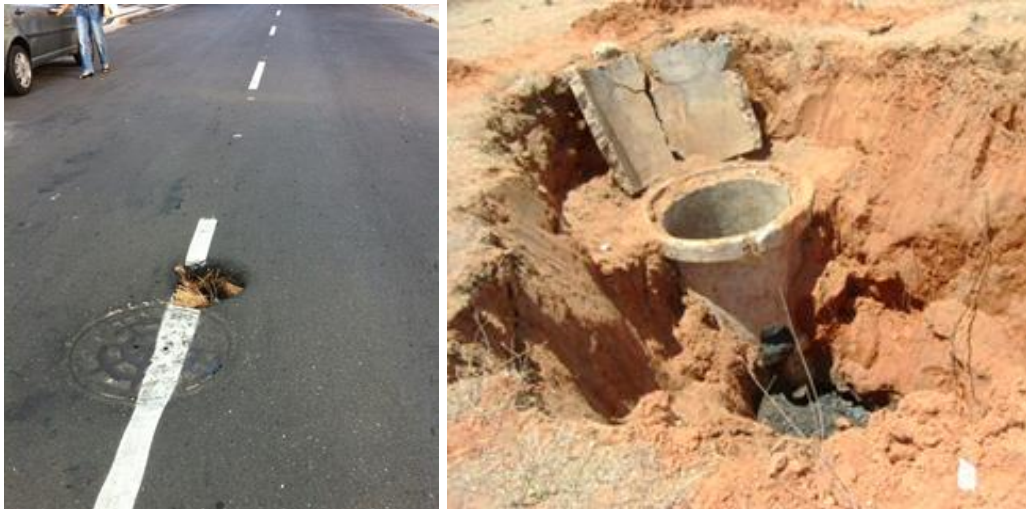
Figura 2.3 – Fotos de abatimento do solo próximo ao PV (fuga)
