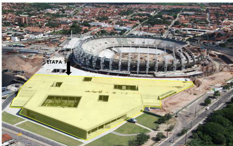
Figura 9 - Edifício sede da Sesporte e estacionamento coberto 1
