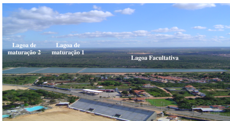
Figura 1 - Vista do sistema de tratamento de esgotos localizado no bairro de Ponta Negra, Natal/RN.
