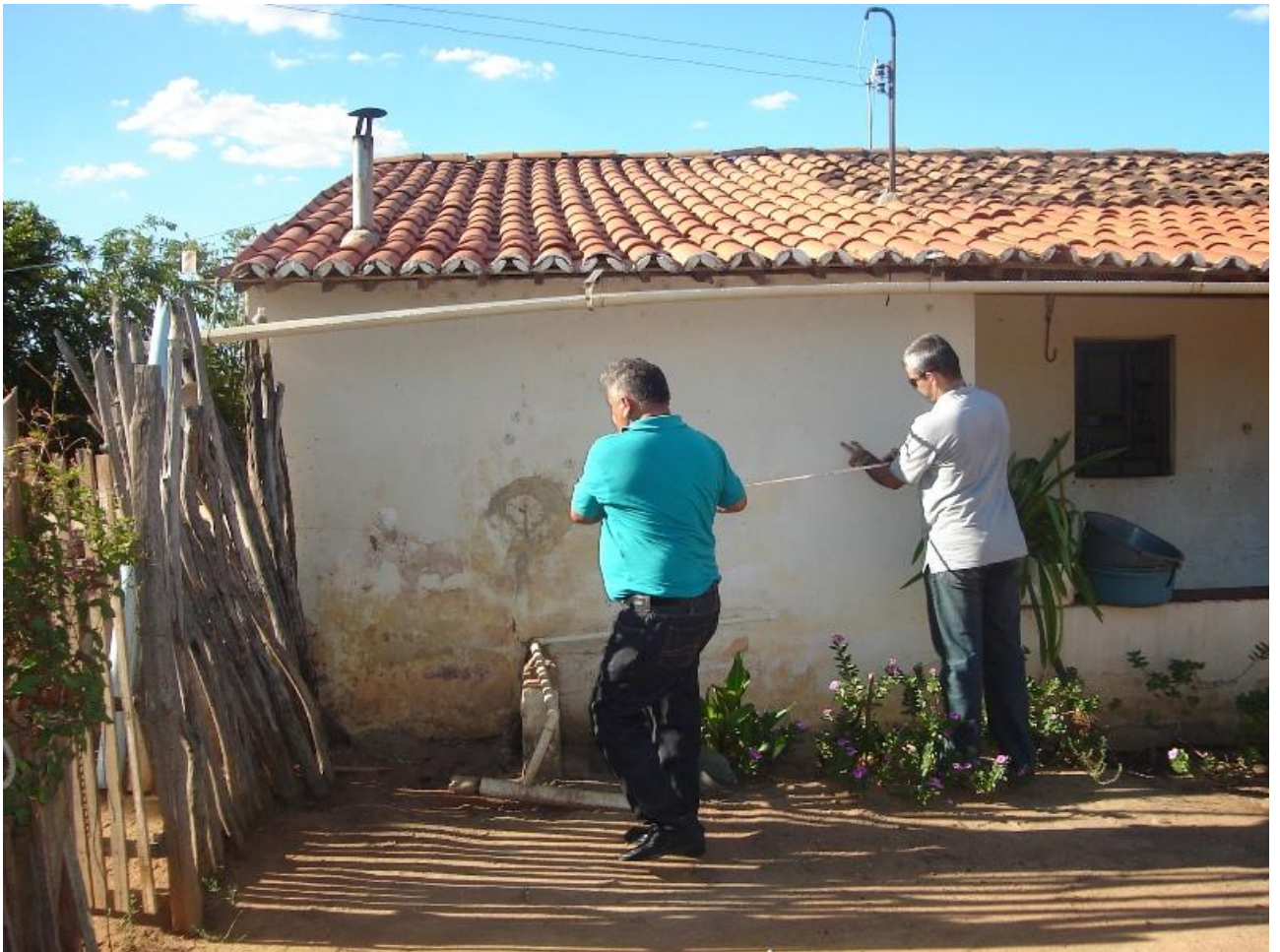
Figura 3 – Medição em campo da área de captação de telhado para alimentar as cisternas.
