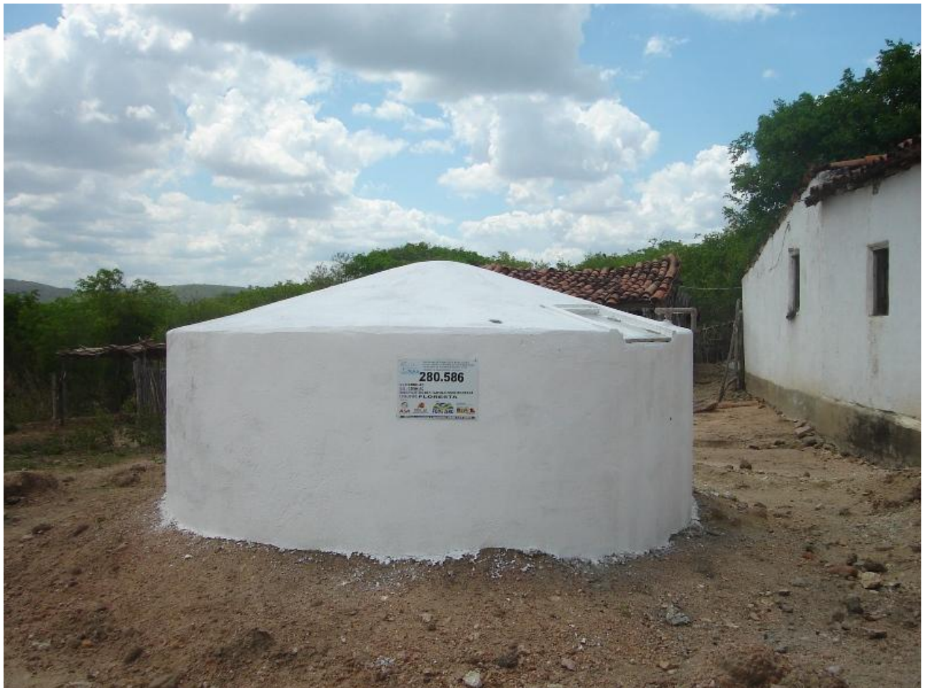
Figura 2 – Cisterna de placas construída no âmbito do P1MC no distrito de Floresta em Deputado Irapuan Pinheiro-CE.
