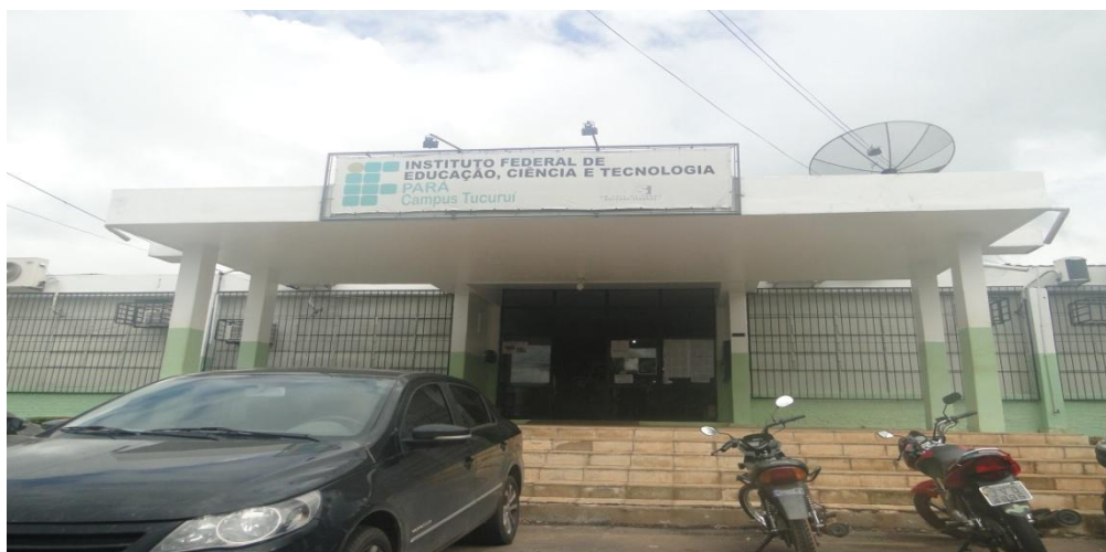
Figura 7 - Imagem da entrada principal do prédio do IFPA/Campus Tucuruí
