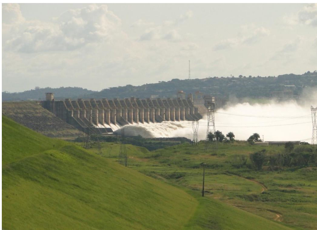
Figura 2 - Imagem da Usina Hidrelétrica (UHE) Tucuruí
