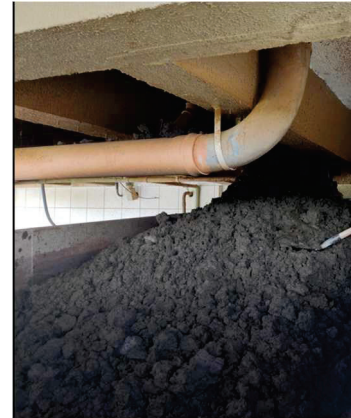
b) coleta do lodo em caminhão estacionário
