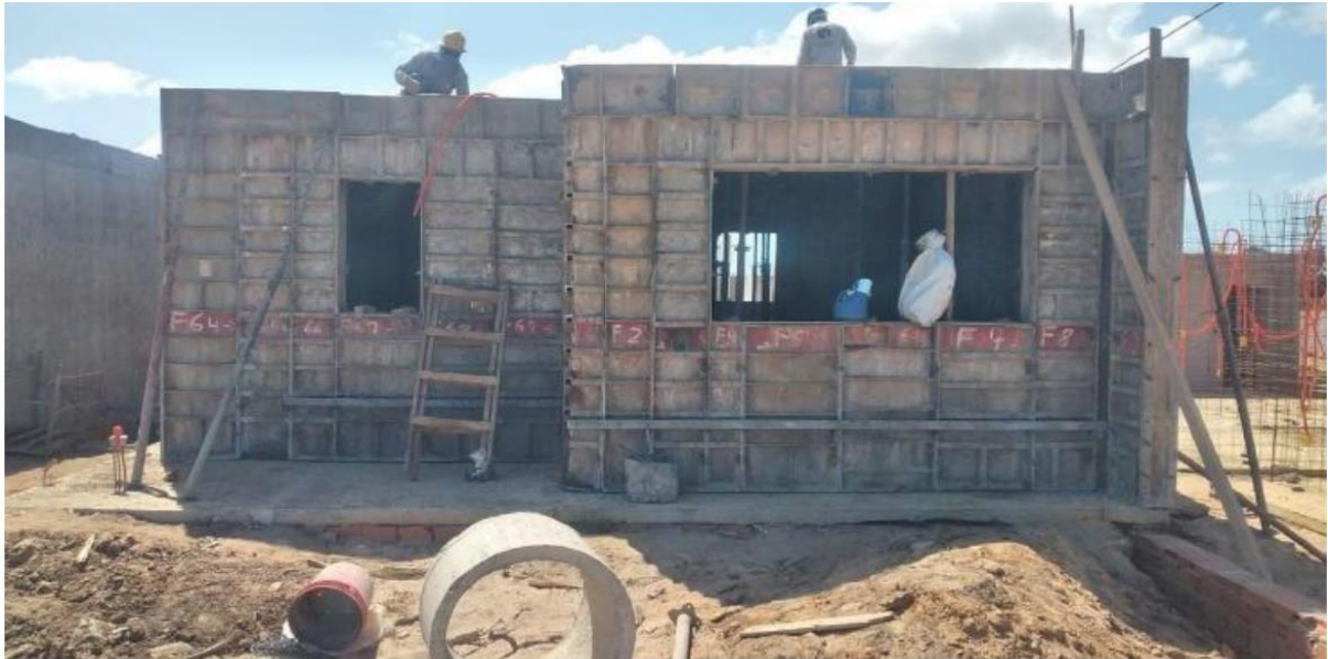
Figura 2 – Paredes de concreto moldadas “ in loco ” para casas populares
