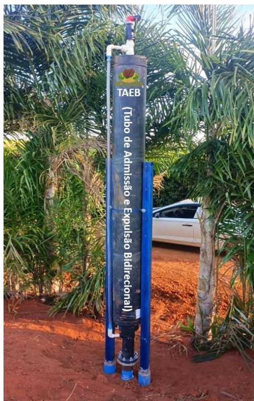
Figura 110 – Disposição final do TAEB, após o reaterro das valas e instalação do tubo de acrílico
