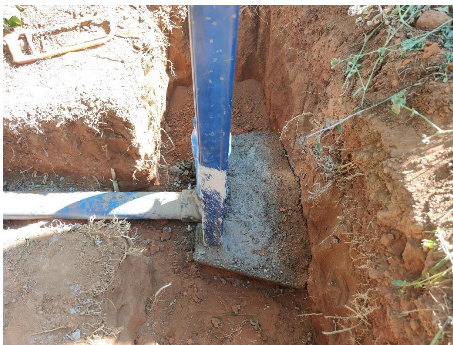
Figura 108 – Posicionamento do bloco de ancoragem do TAEB
