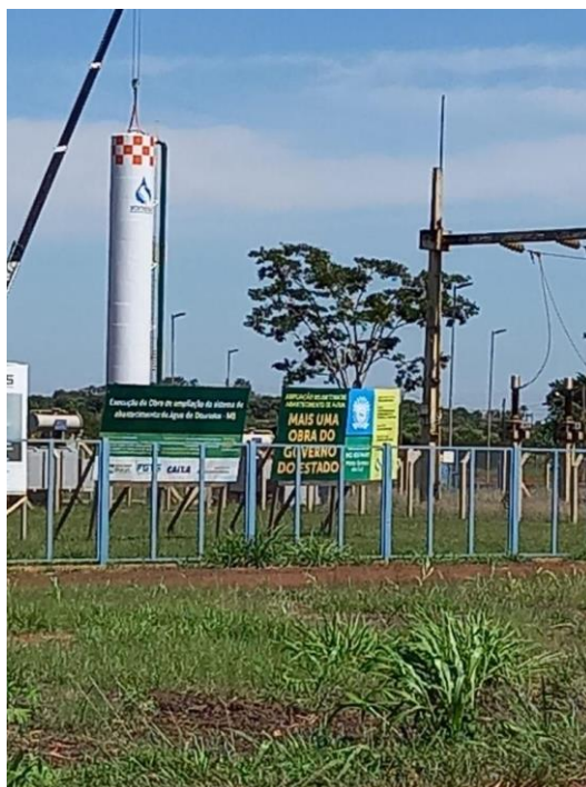
Figura 16 – Tanque de Alimentação Unidirecional presente em adutora no Mato Grosso do Sul
