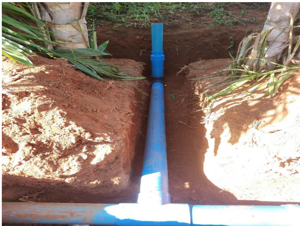
Figura 107 – Construção da derivação onde foi instalado o TAEB
