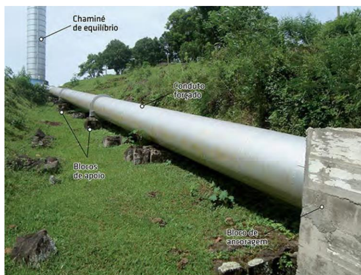
Figura 15 – Chaminé de Equilíbrio presente na Central Hidrelétrica do Rio Tigre
