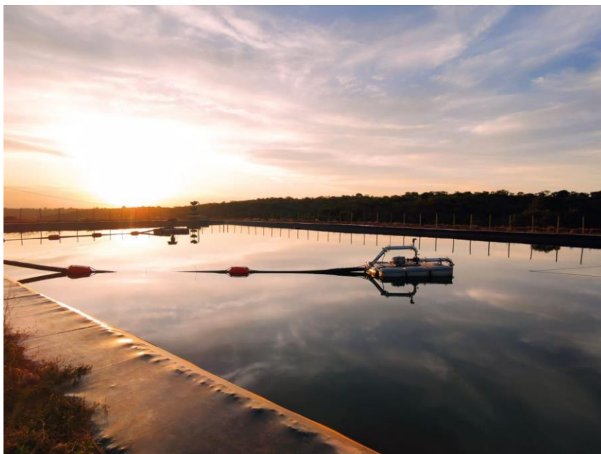
Figura 105 – Posicionamento do conjunto motobomba da adutora
