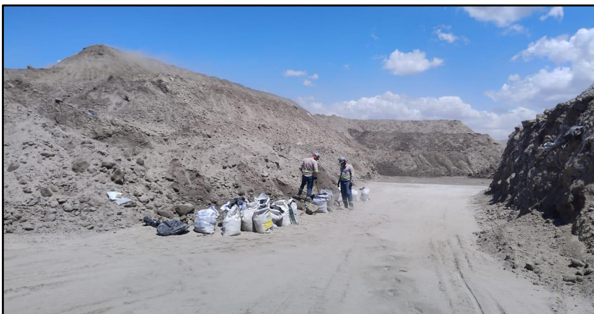
Figura 10 - Local de coleta da cinza leve no pátio das instalações da empresa Apodi.
