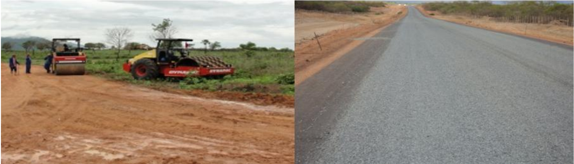
Figura 06: Estrada Araquém-Coreaú em obras em maio de 2010 e asfaltada em novembro de 2010, respectivamente.
