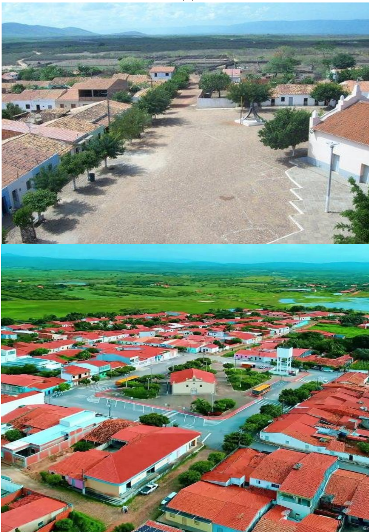
Figura 13: Núcleo do distrito antes do asfaltamento em 2009 e depois do asfaltamento em 2025
