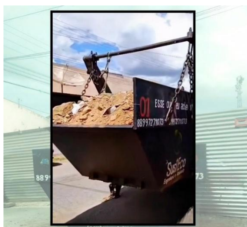
Figura 2- Caçamba estacionária com entulho
