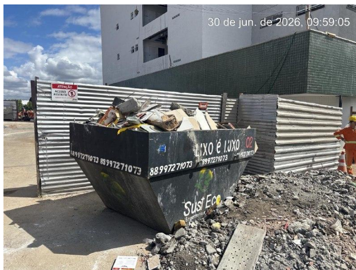
Figura 3- Caçamba estacionária utilizada em obra
