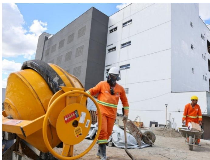
Figura 4- Avanço da Obra do Hospital Regional de Crateús (atualmente denominado Hospital Universitário dos Sertões de Crateús – Hospital São Lucas
