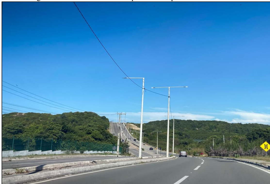
Figura 3 – Rodovia CE – 025 duplicada com ponte sob o Rio Pacoti.
