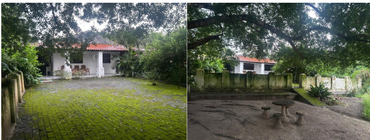
Figura 35 - Registros atuais da residência da professora Judite Pacheco de Araújo: entorno da casa e fachada com alpendre.
