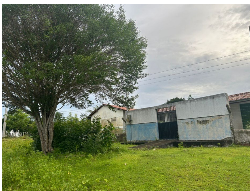
Figura 18 - Prédio da antiga E.E.B. Inocência Gonçalves Muniz, atualmente paralisada, comunidade de Trapiá, Itapipoca-CE
