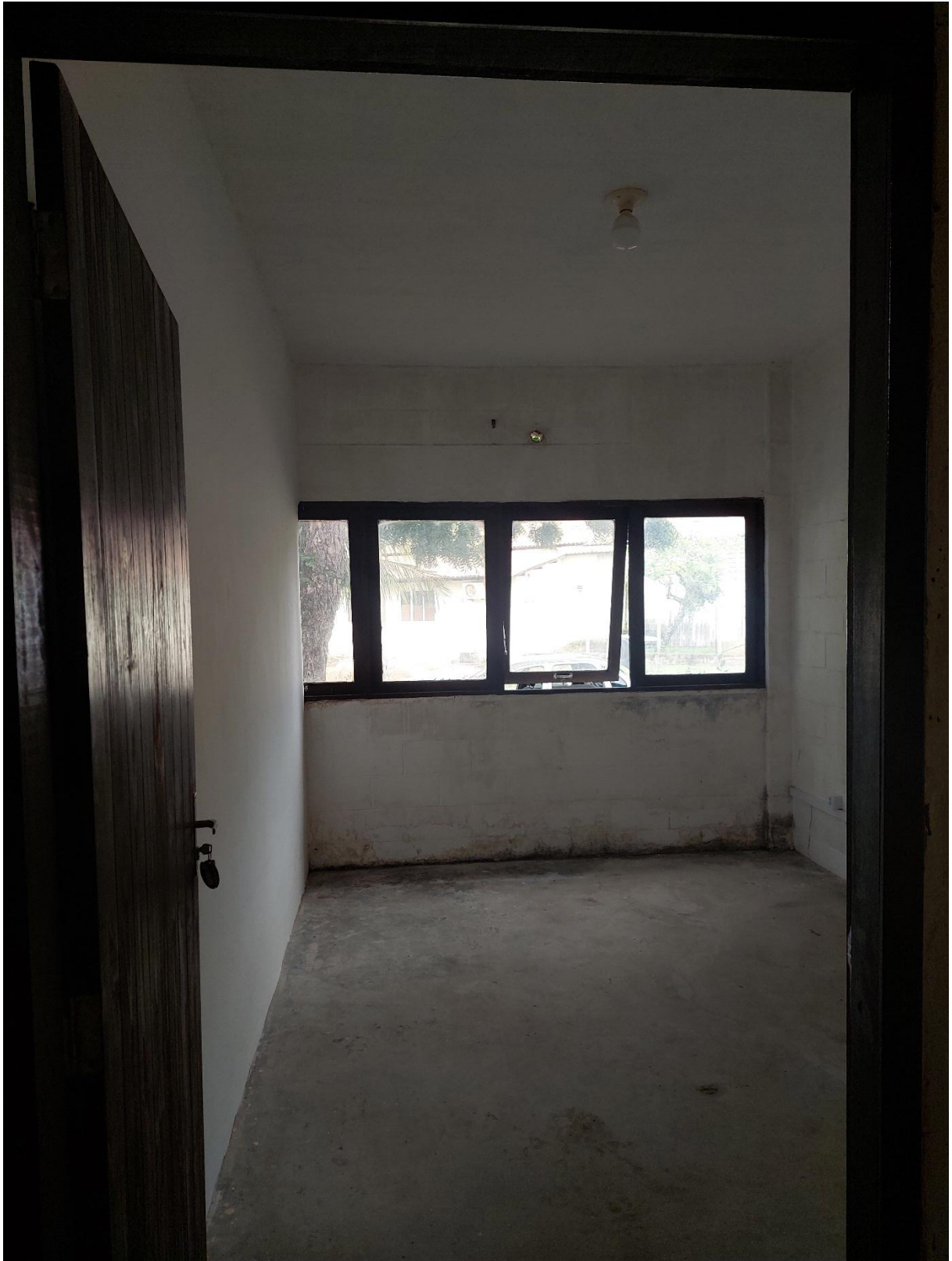
Figura 16 – Sala 2 do PEAM que será destinada a sala imersiva do programa fotografada em 18 de março de 2026.
