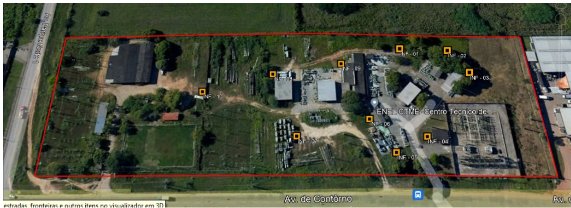
Figura 48 - Localização dos ensaios de absorção
