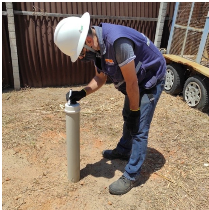
Figura 27 - Poço de inspeção
