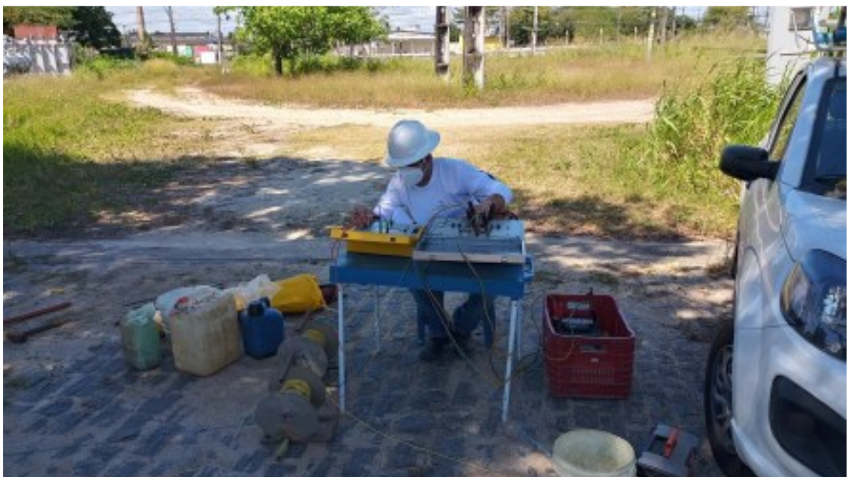
Figura 17 - Localização da linha de pesquisa 01, junto ao muro lateral norte da área de estudo
