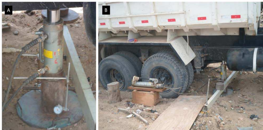
Figura 4 - Prova de carga direta a) Equipamento utilizado b) Vista da execução e do sistema de reação.
