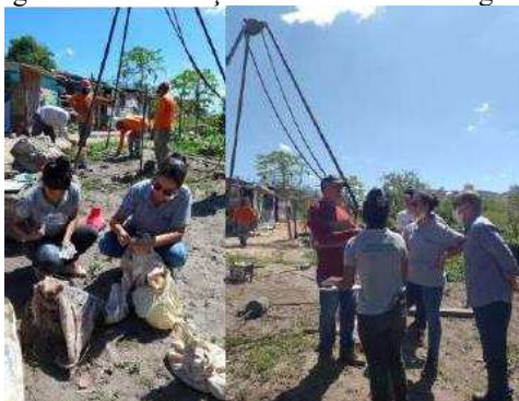
Figura 11: Registros da realização do ensaio de sondagem à percussão.
